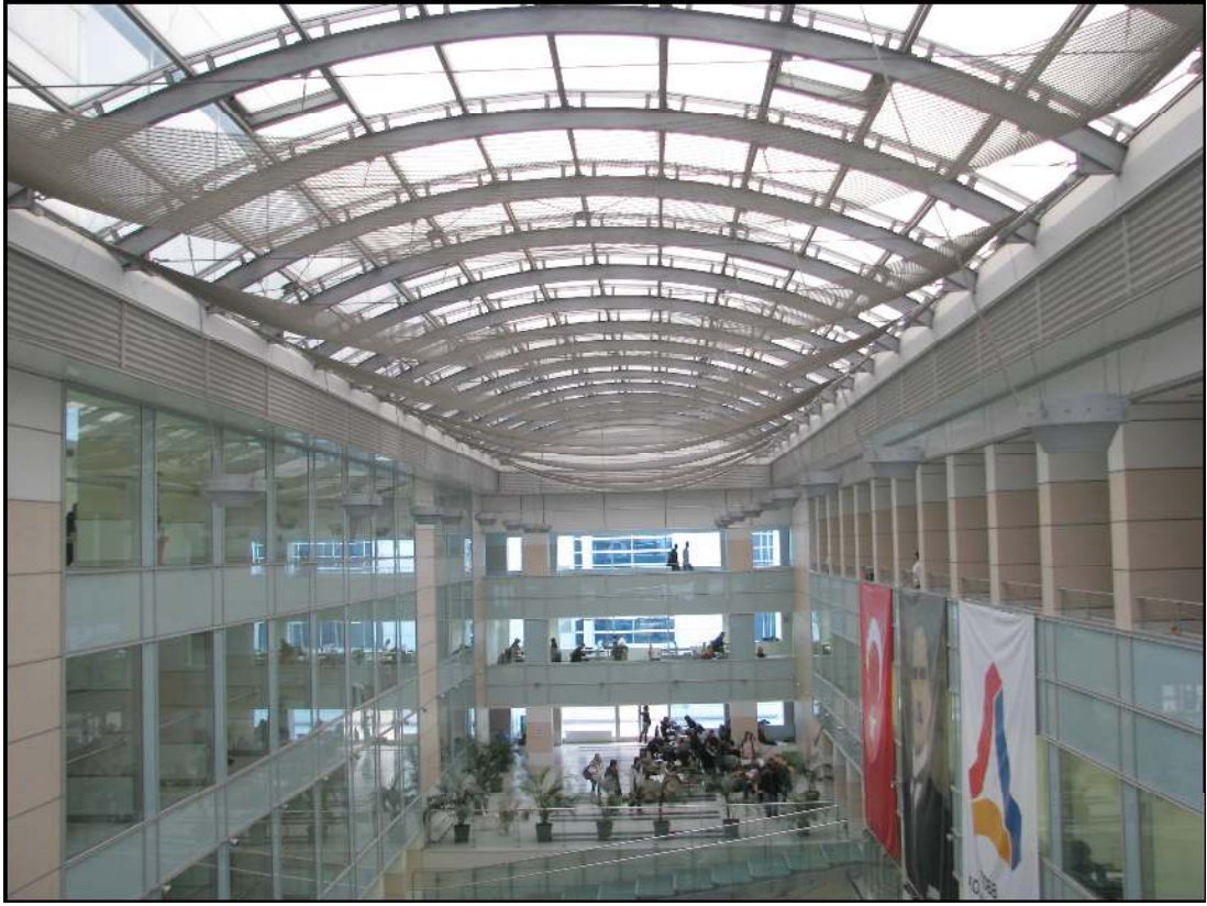
Resim 4.2. Çatı ışıklığının file ile kapatılması ve yapay aydınlatma aygıtları
