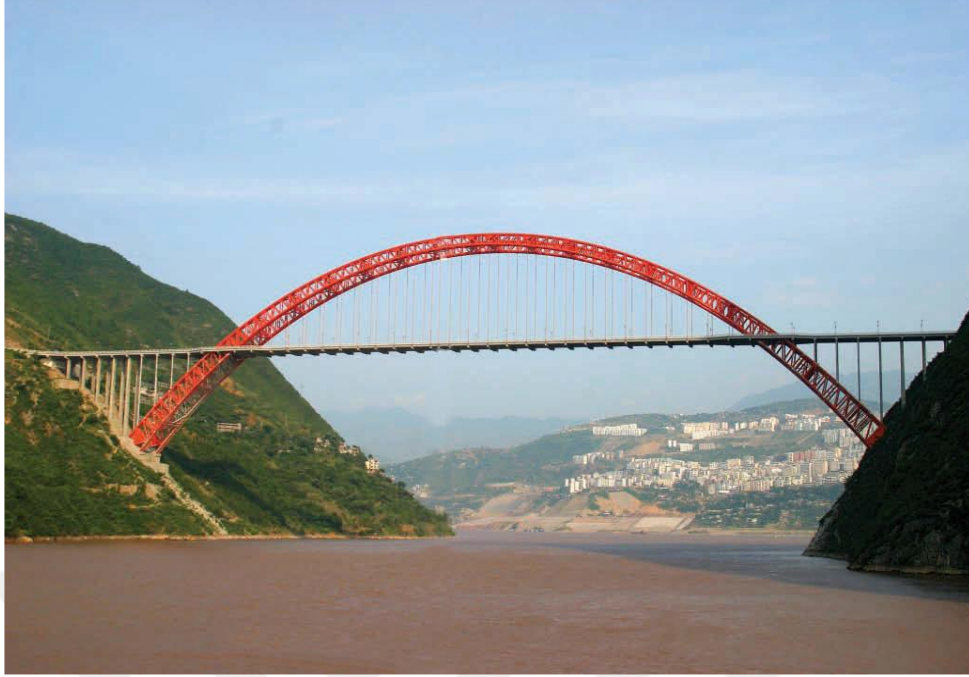
Şekil 2.71. CFST Wushan Yangtze Nehri Köprüsü (Roca vd. 2019).
