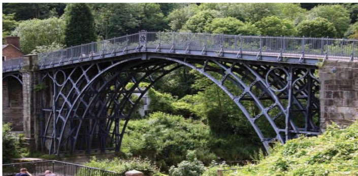
Şekil 2.73. Severn Nehri Üzerindeki Coalbrookdale'deki Yol Köprüsü (Roca vd. 2019).
