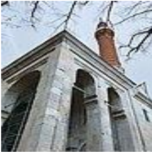
Şekil 2.27. Bursa Yıldırım Camii (Anonim 12).
