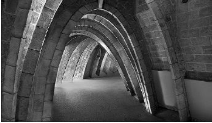
Şekil 2.80. Barselona'daki Mila Evindeki Diyafram Kemerlerinin Tasarımı (Sonavane, 2014).
