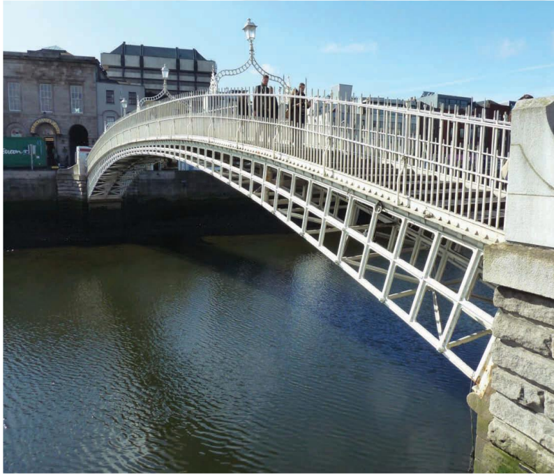
Şekil 2.75. Dublin'deki Liffey Köprüsü (Roca vd. 2019).
