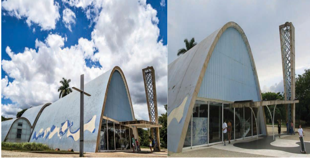
Şekil 2.105. Çubukların İnce Kapağı Olduğu İçin Kısa Dayanıklılık Gösteren RC Kabukları ve Betonun Sıkıştırılması Zor Olan Brezilya Pampulha’da Bulunan Assisi Francis Kilisesi Yapısı (Roca vd. 2019).
