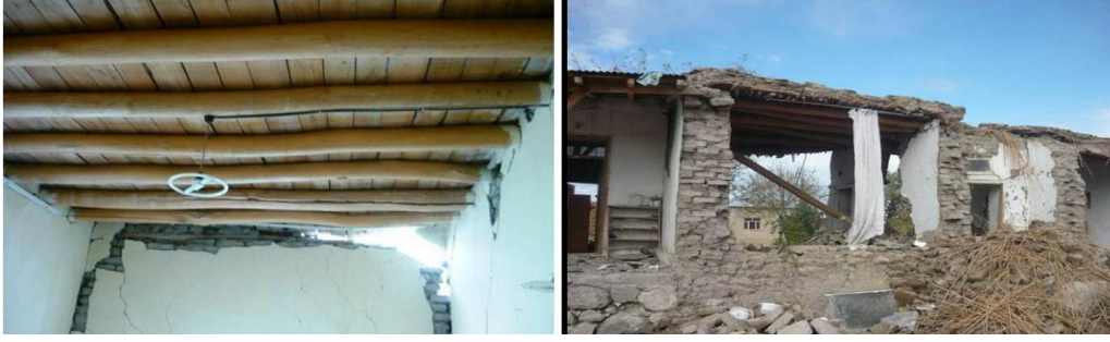
Şekil 3.11 Van yöresinde kırsalda yaygın olan kerpiç yapıların durumu (Kızılkıran A., vd.,2011)
