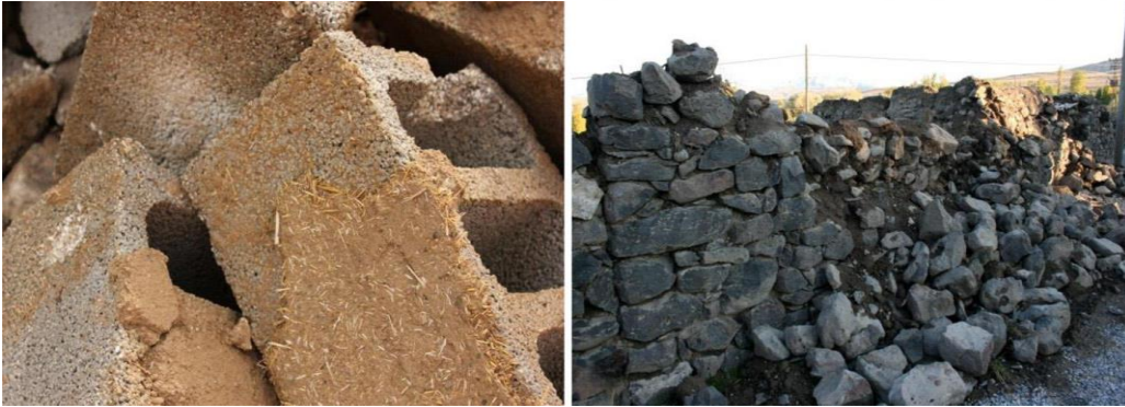
Şekil 3.13 Beton blok ve kerpiç harç (solda), taş ve kerpiç harç (sağda)
