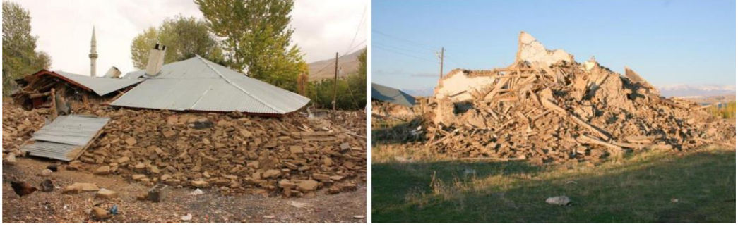
Şekil 3.14 Dağönü (solda) ve Yaylıyaka'da (sağda) köylerinde, tamamen çöküş kerpiç yapılar
