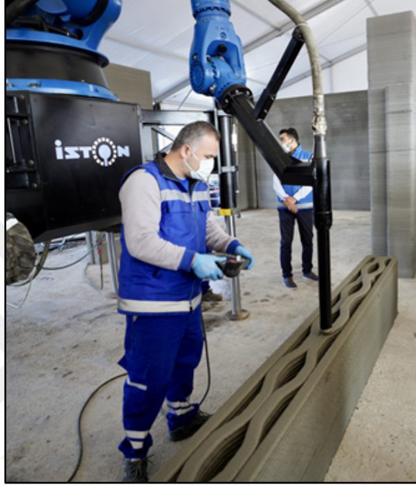
Resim 2.1 İSTON Türkiye’de 3B beton yazıcı teknolojisi ile bina inşası (İnt.Kyn.7)
