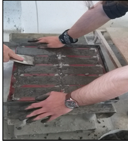
Resim 3.9 Hazırlanan harcın kalıbına yerleştirilmesi ve vibrasyon işlemi.
