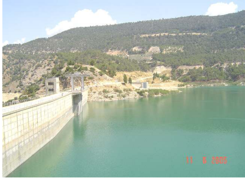
Şekil 8. Kemer Barajı'ndan Bir Görünüm
