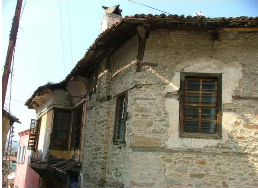
Şekil 85. Sandıkçılar Reşit Konağı.
