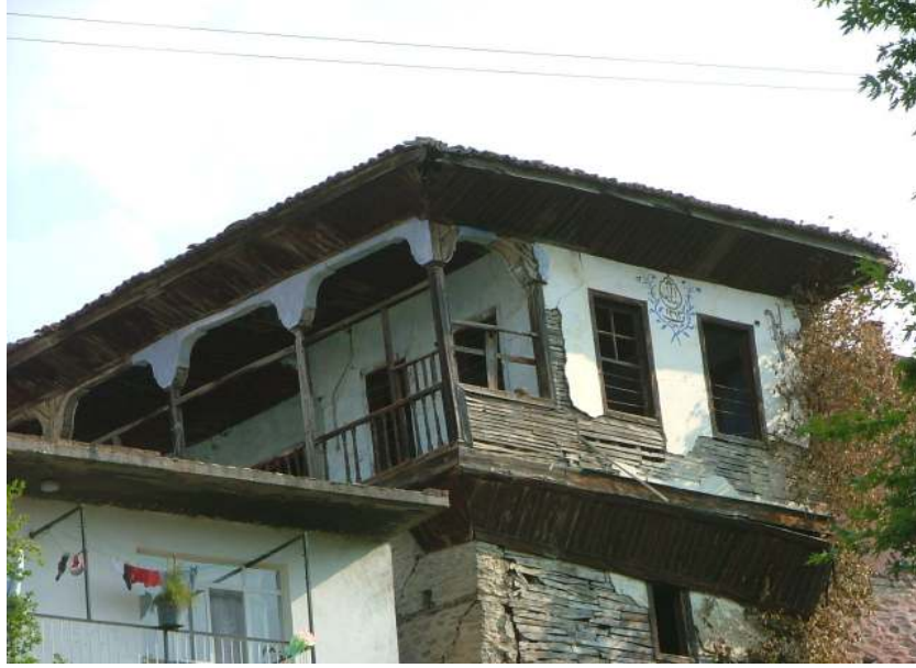
Şekil 80. Kallemler Konağı Yan Cephe
