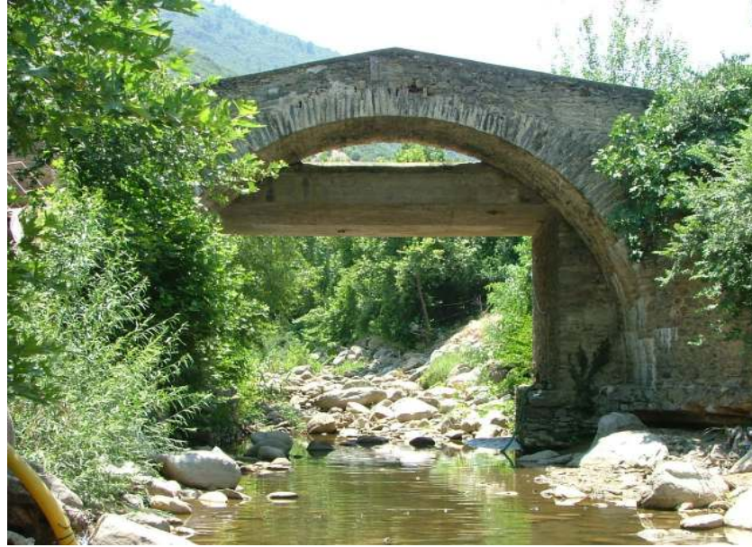
Şekil 56. Kazandere Köyü'ndeki Köprü
