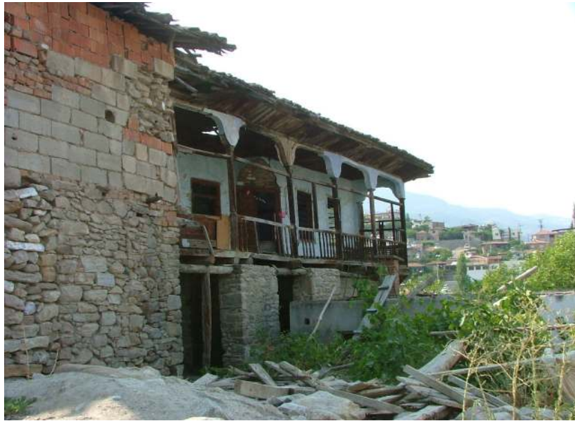
Şekil 79. Kallemler Konağı Ön Cephe
