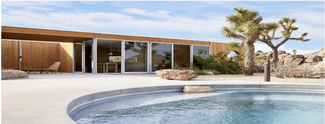
Şekil 5.37. Dış cephe (URL-64)
