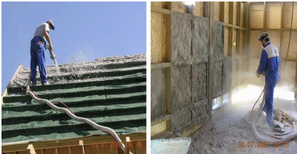
Şekil 5.6. Çatı ve duvar yalıtımı (URL-33)
