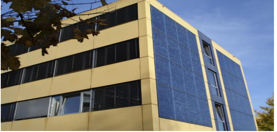
Şekil 3.13. Duvar tipi güneş pili (URL-16)
