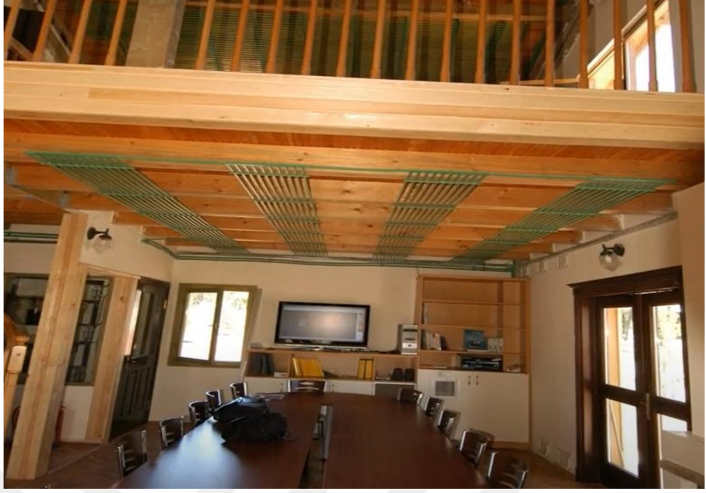
Şekil 5.4. Isıtma-soğutma sistem detayı (URL-31)
