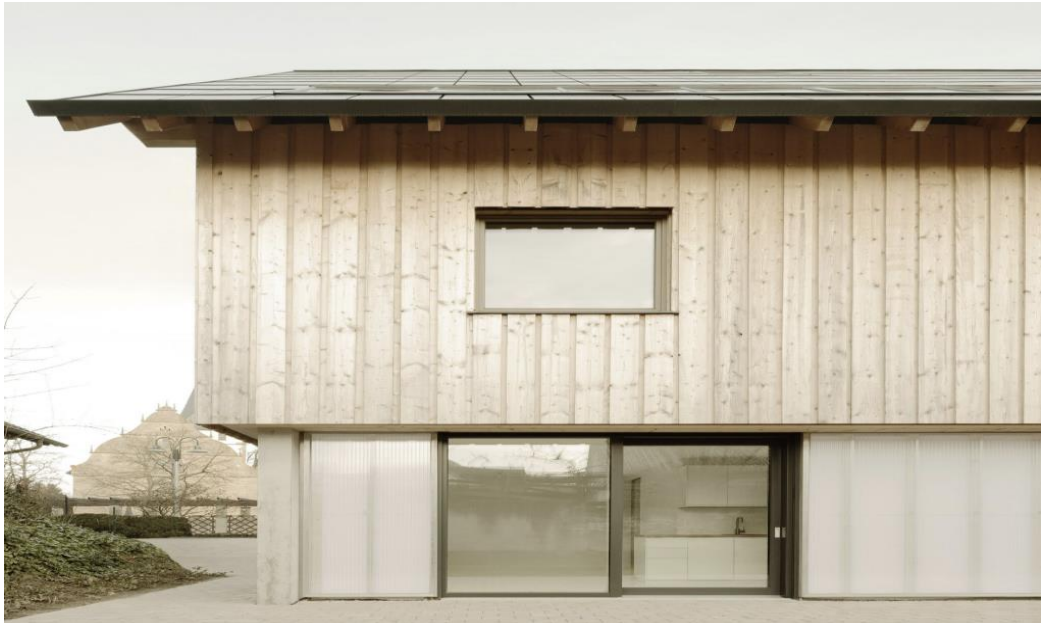
Şekil 5.48. Saman yalıtımlı ahşap cephe (URL-75)
