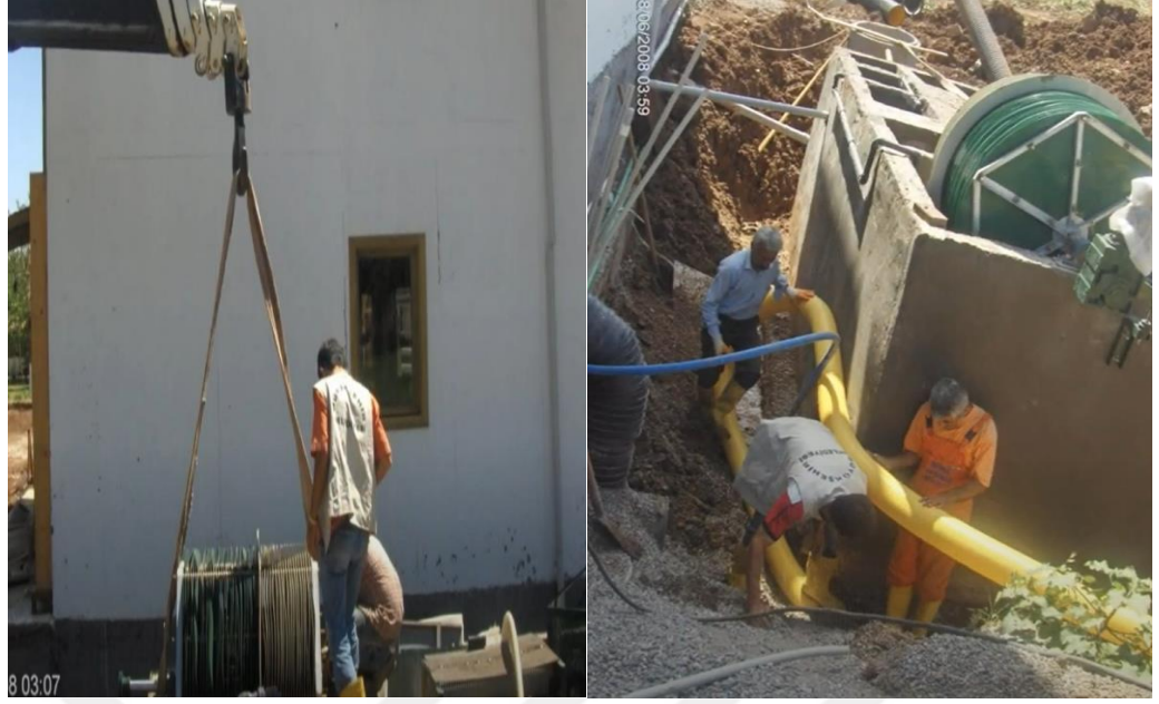
Şekil 5.9. Biyolojik arıtma diskinin montajı (URL-36)
