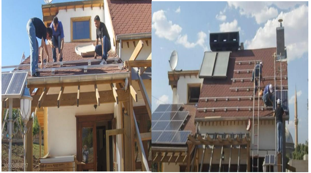
Şekil 5.8. Panel ve kolektör montajı (URL-35)
