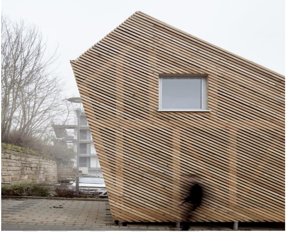
Şekil 5.61. Dış cephe (URL-88)
