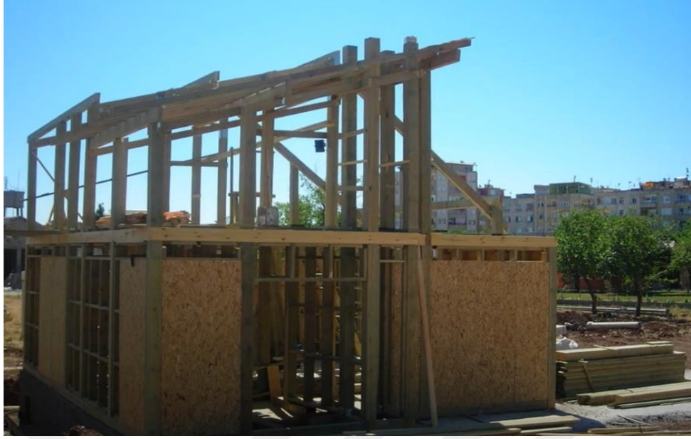
Şekil 5.10. Ahşap taşıyıcı sistem (URL-37)
