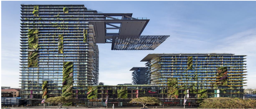
Şekil 5.26. Dış cephe (URL-53)
