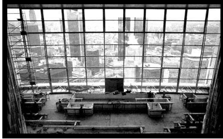
Şekil 4.36 Cepheye içeriden bir bakış
