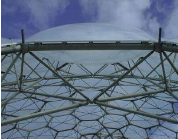
Şekil 4.53 Üç katmanlı kaplama malzemesi
