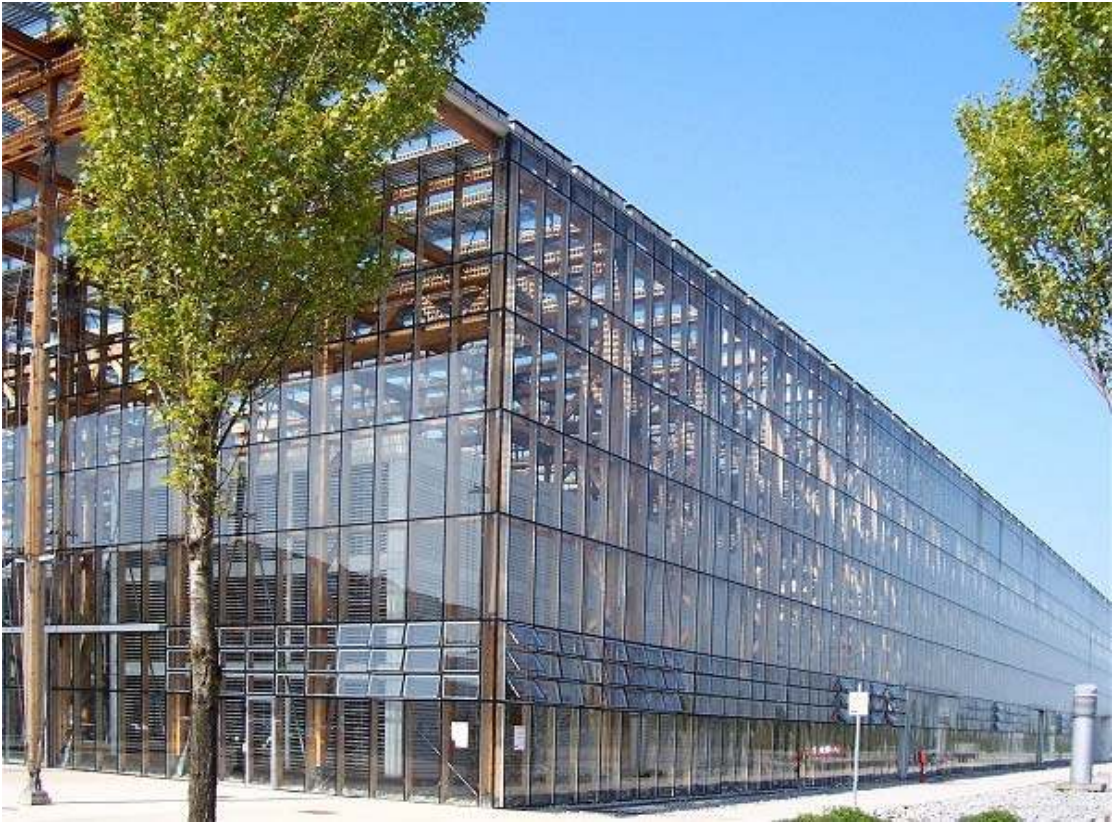
Şekil 4.84 Akademi Binasının Genel Görünüşü
