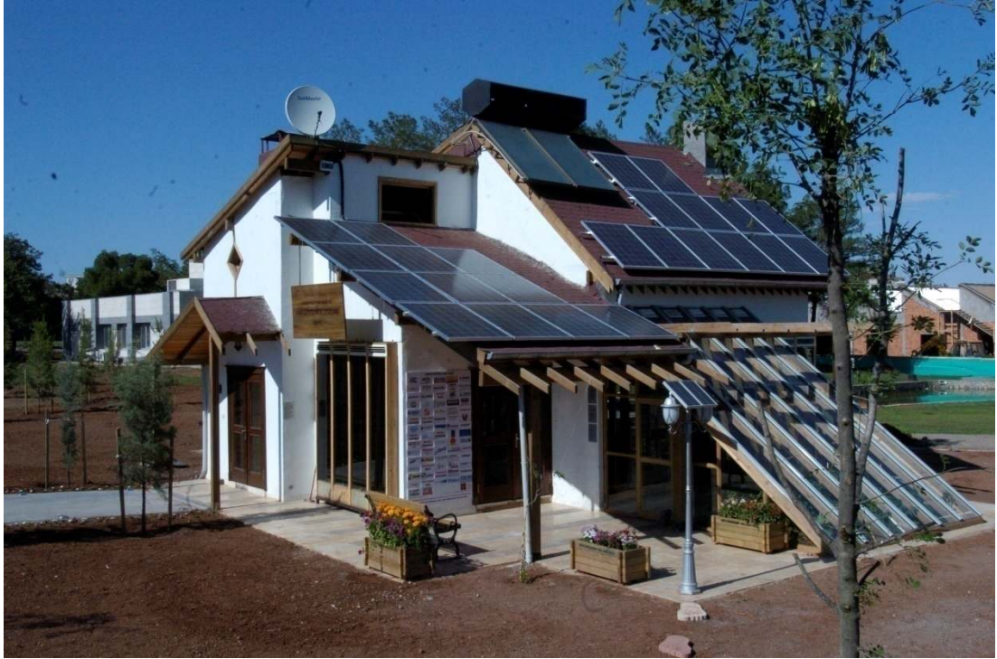
Şekil 4.89 Binanın çatısına konulan fotovoltaiikler
