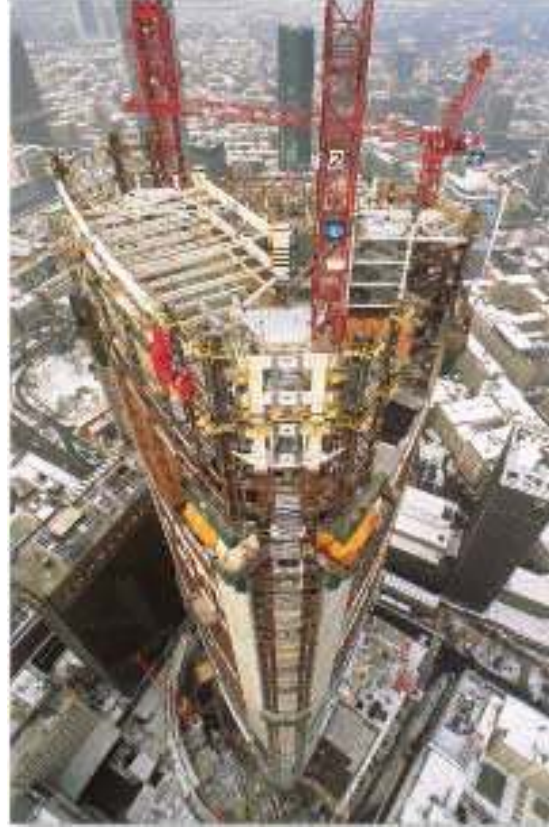
Şekil 4.42 Binanın inşaat aşamasından görünüm
