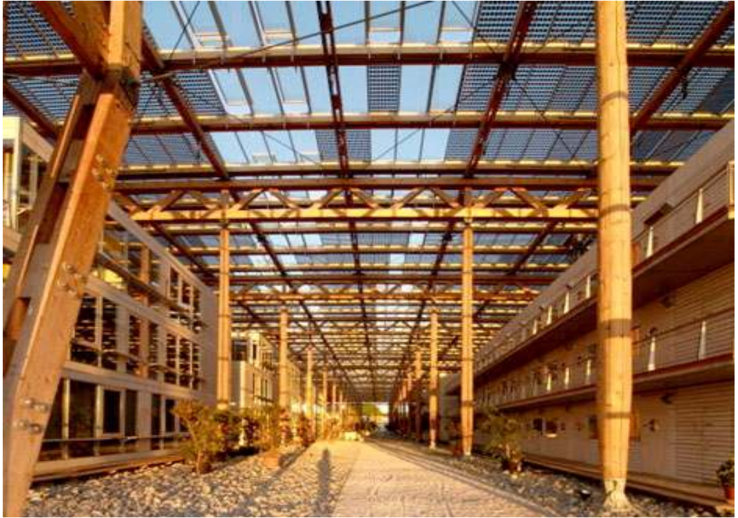
Şekil 4.78 Mont-Cenis Akademi Binasının Çatı Strüktürünün İçeriden Görünümü
