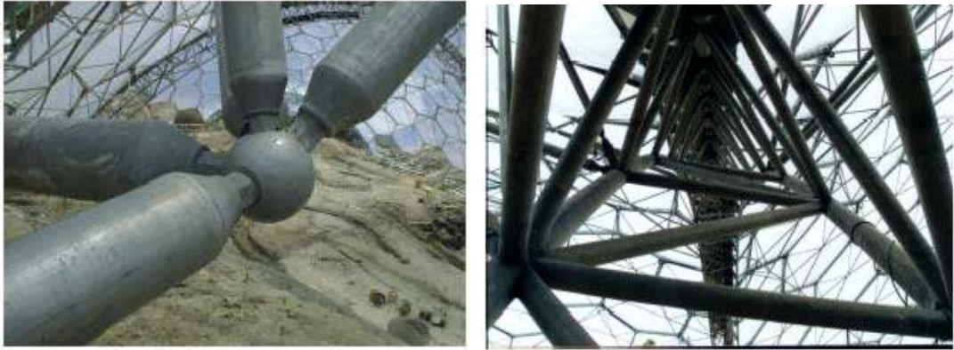
Şekil 4.60 Jeodezik kubbelerin profil birleşim detayları
