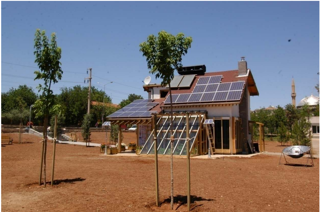
Şekil 4.88 Binanın çatısına konulan fotovoltaikler
