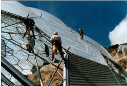
Şekil 4.55 Biomelara kaplama malzemesinin montajı
