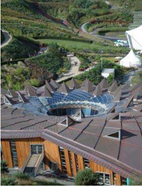
Şekil 4.56 Çekirdek binasının görünümü
