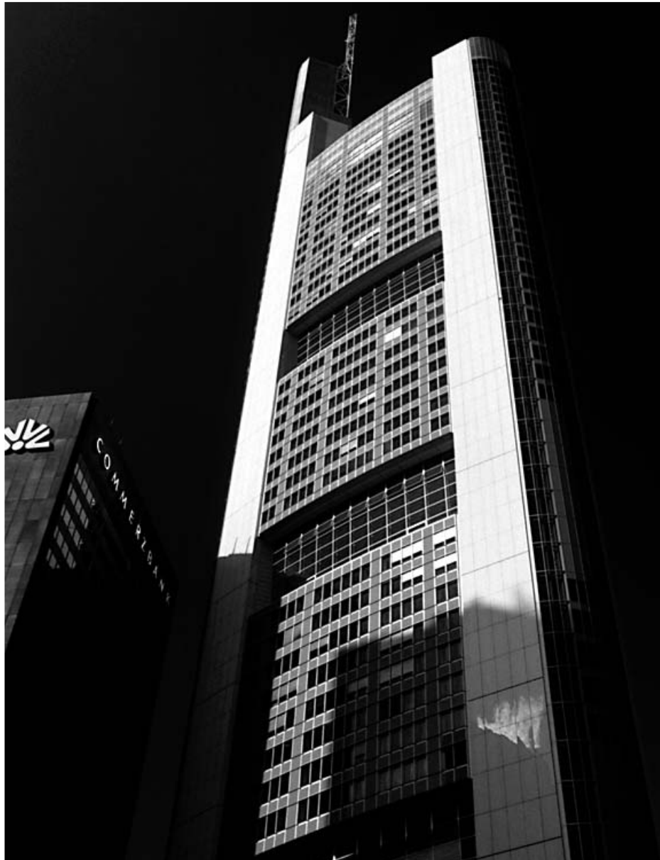
Şekil 4.43 Binanın genel görünümü
