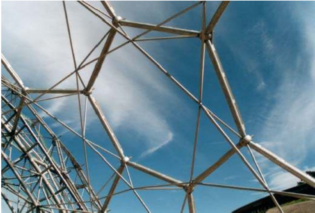
Şekil 4.50 Çift katmanlı jeodezik kubbe detayı
