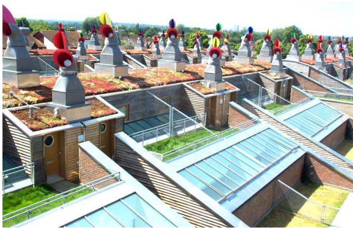
Şekil 4.72 Rüzgar Bacaları
