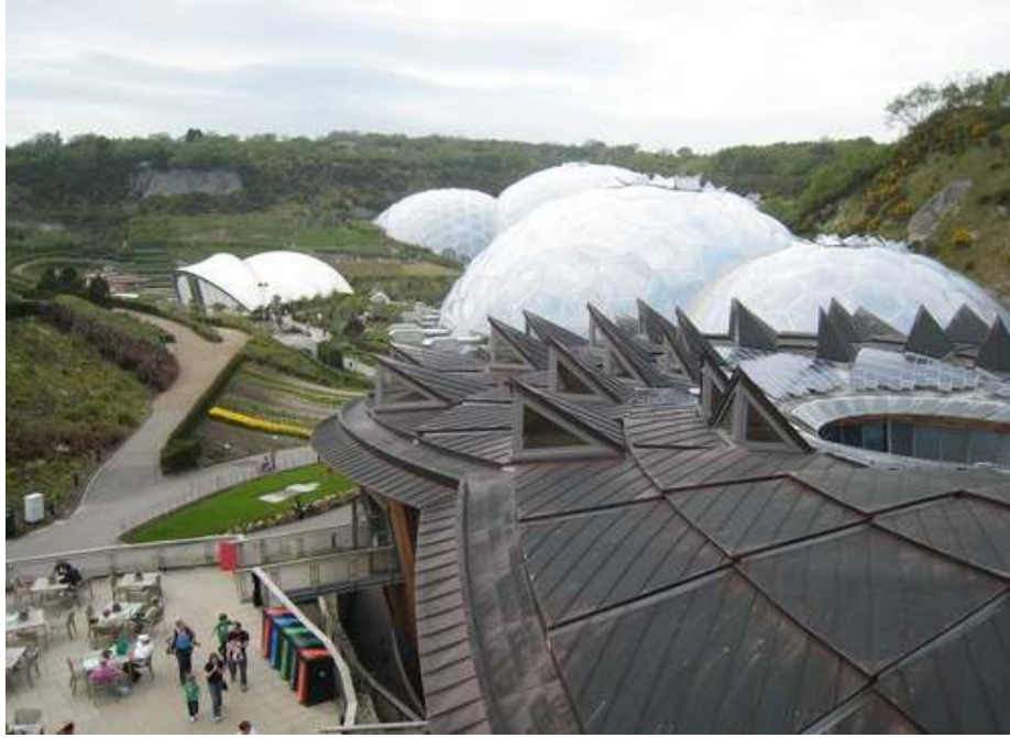
Şekil 4.57 Çekirdek binasının görünümü
