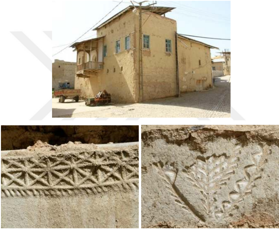
Şekil 39. Üstte Malatya Balaban geleneksel kerpiç evi ve altta Balaban evi Kerpiç Duvar Süslemeleri
