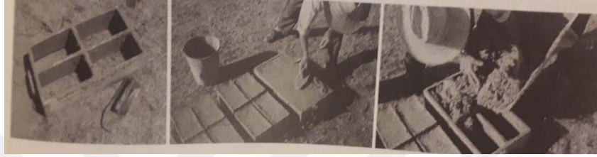
Şekil 7. Üstte Anadolu’ya özgü analı-kuzulu kerpiç kalıpları ve altta kerpiç blok dökümü (Kafesçioğlu, 2018)
