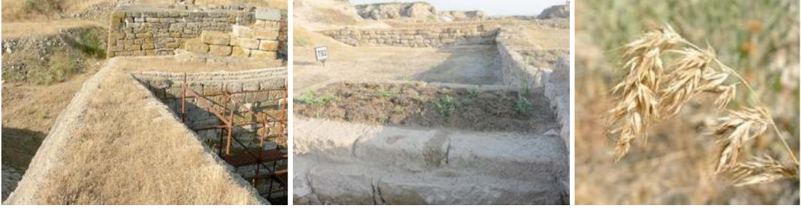
Şekil 35. Solda İç Kale Kapısı Binası, ortada Teras Bina Duvarları, sağda salkımotu bitkisi.
