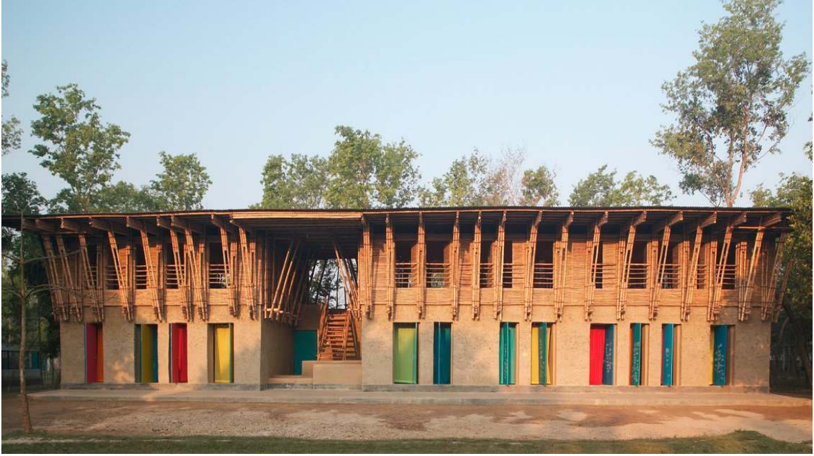
Şekil 52. Bangladeş, METI İlkokulu Binası, 2007.
