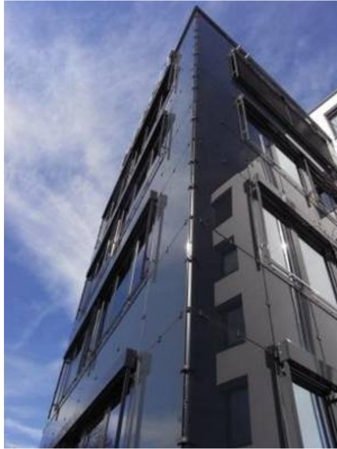
Şekil 3.24 Giydirme cephede şeffaf fotovoltaiik panel uygulaması örneği- Jako Bau Binası/Almanya.
