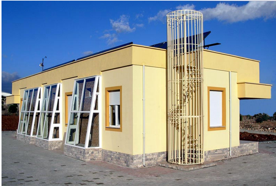
Şekil 3.16 Trombe duvarı uygulanmış bir yapı örneği. (Pamukkale Üniversitesi Laboratuvar Binası, http://pau.edu.tr/tee/sayfa2433.aspx )
