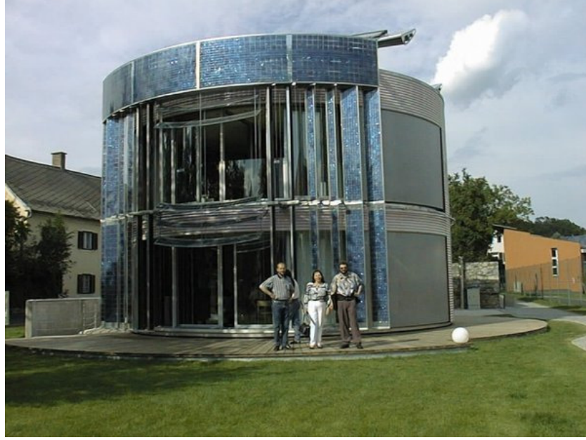
Şekil 3.25 Fotovoltaik panellerin dairesel formda kullanım örneği- Stryia Country ( http://chicagosolararchitects.com/wordpress/?tag=solar-energy )
