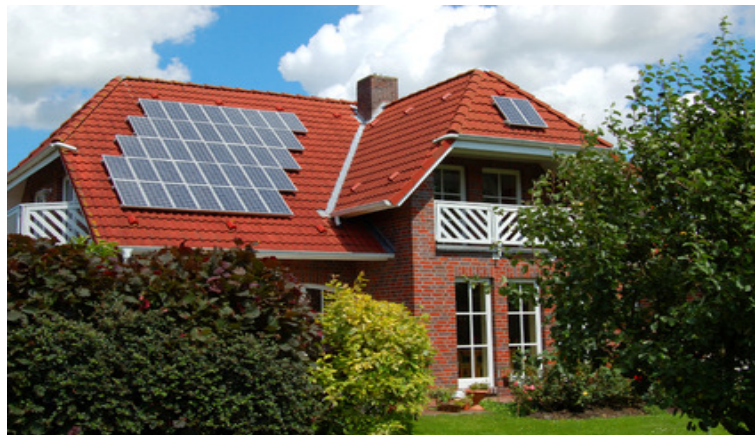
Şekil 3.23 Konut çatısında fotovoltaik panel kullanımı örneği.
