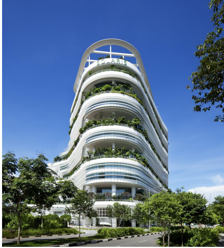
Şekil 29. Solaris Tower Projesi
