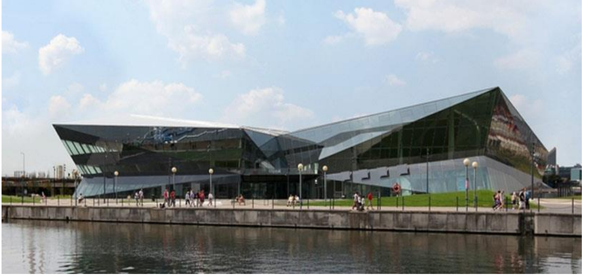
Şekil 13. The Crystal Binası Ön Cephe
