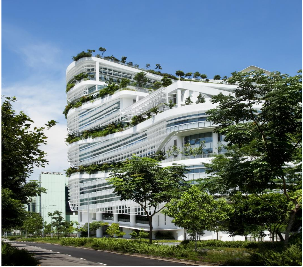
Şekil 33. Solaris Tower Projesi
