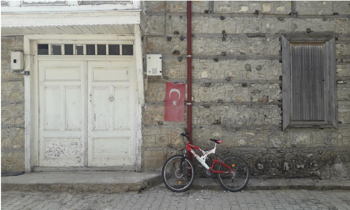
Fotograf 5.9 Evlerin 2 kanatlı geniş giriş kapısı (Porta) ve sağ tarafta ahıra yük boşaltılan pencere Ormana/İbradı (24.10.2020).
