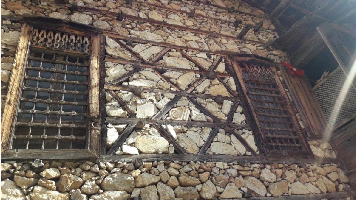
Fotoğraf 5.26 Ormana Mahallesi'nde ocak arkası duvarının inşaatında antik taş kullanılan bir düğmeli ev görünümü (24.10.2020).
