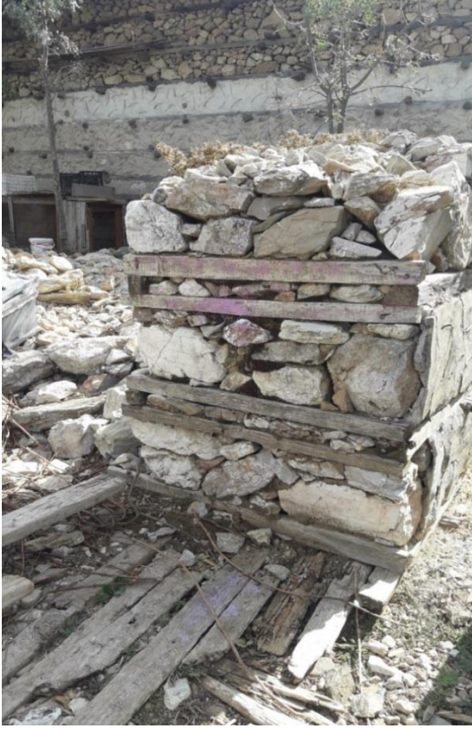
Fotoğraf 5.3 Ormana mahallesinde yıkılan bir düğmeli evin duvar örme tekniğinden bir örnek (25.10.2020).
