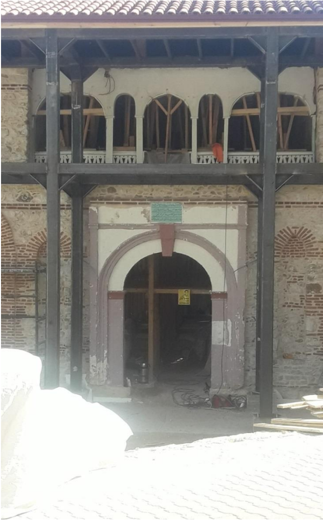
Fotoğraf 5.25 Sururi Vezir Paşa Camii giriş kapısı ve kapı üzerinde bulunan kitabesinden bir görünüm (İbradı /Merkez) (25.10.2020).
