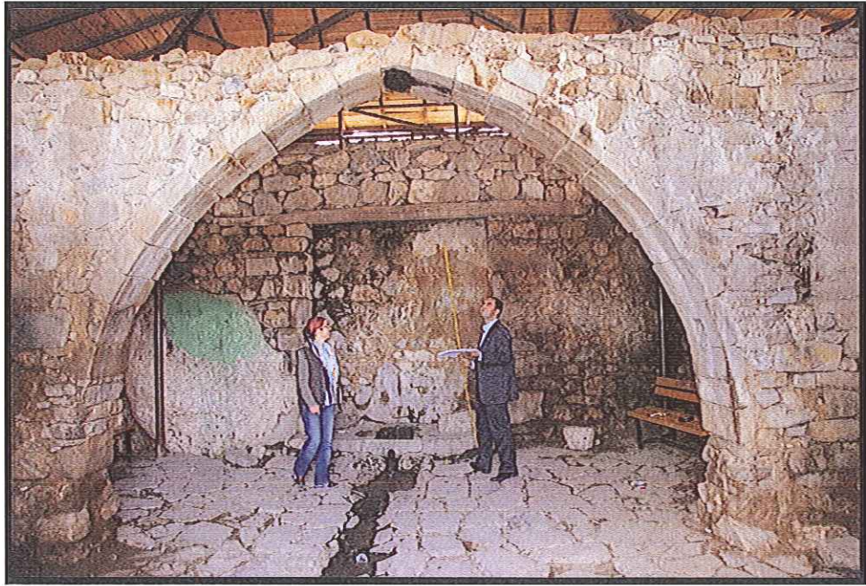
Resim 13: Ulukent Mahallesi Seyit Kasım Çeşmesi
