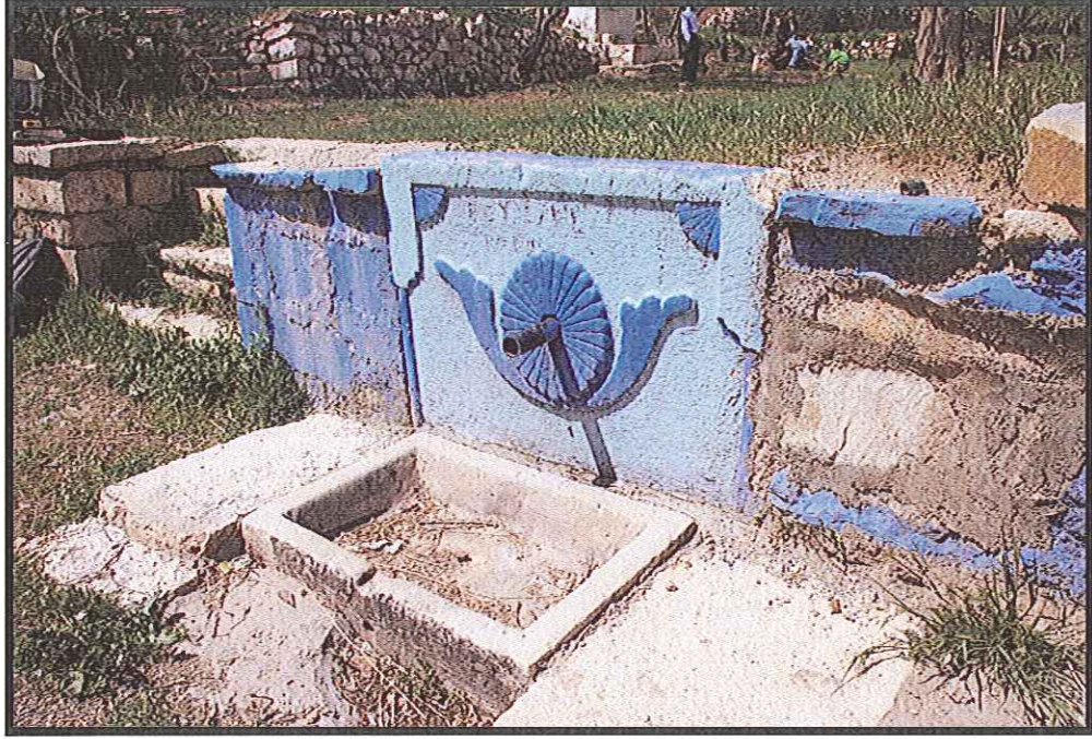
Resim 9: Ulukent Mahallesi Hacı Muharrem Paşa Çeşmesi
