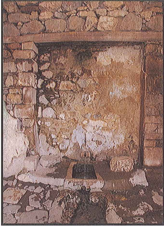
Resim 14: Ulukent Mahallesi Seyit Kasım Çeşmesi
