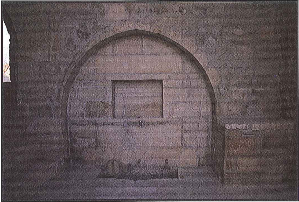
Resim 33: Harput Sara Hatun eşmesi'nin Ön Görünüşü (Onarım Sonrası)
