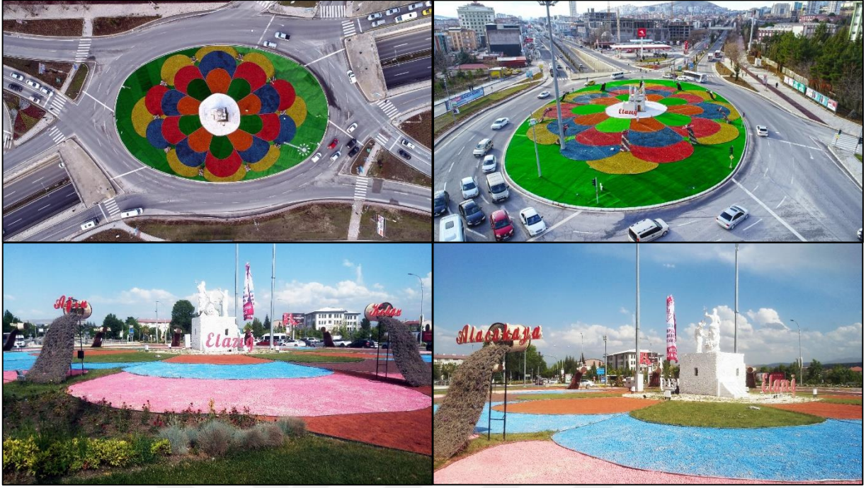
Şekil 4.37. Çaydağra Kavşağı Üsten Görünümü ve Peyzaj Düzenlenmesi (URL-31)
