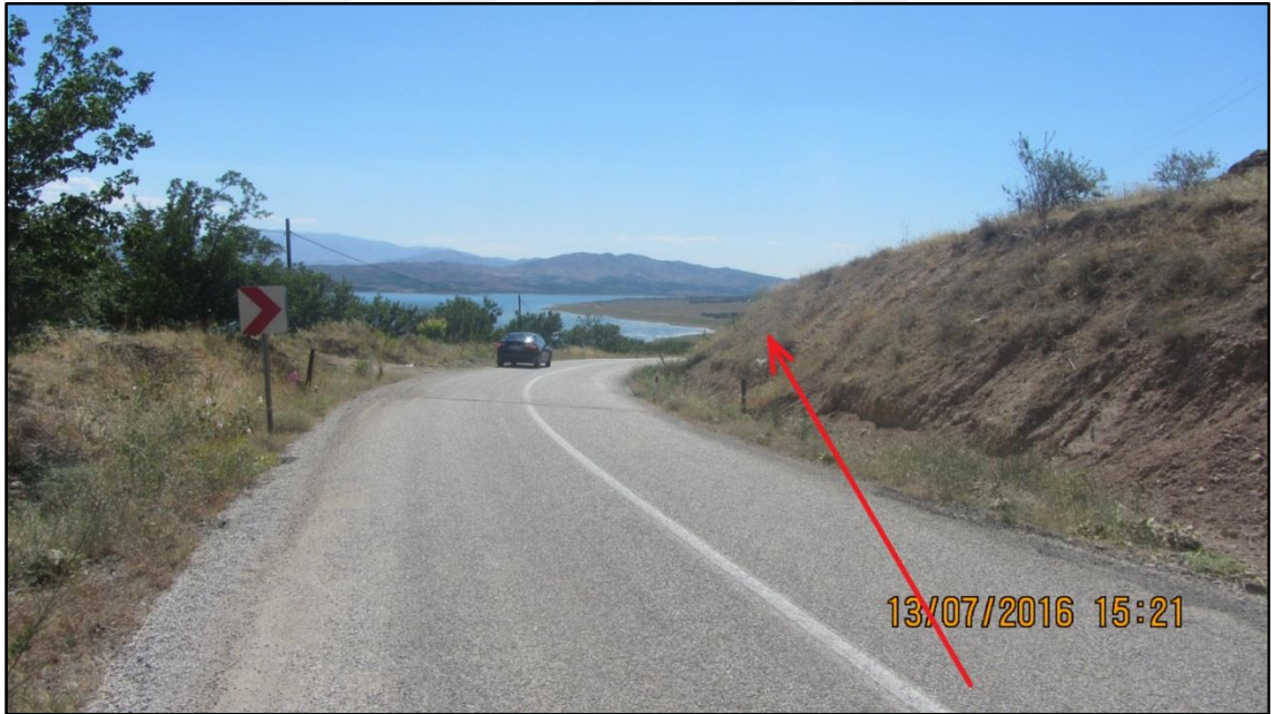
Resim 3.39. Km:10+300-10+750 arası genel görünüm.
