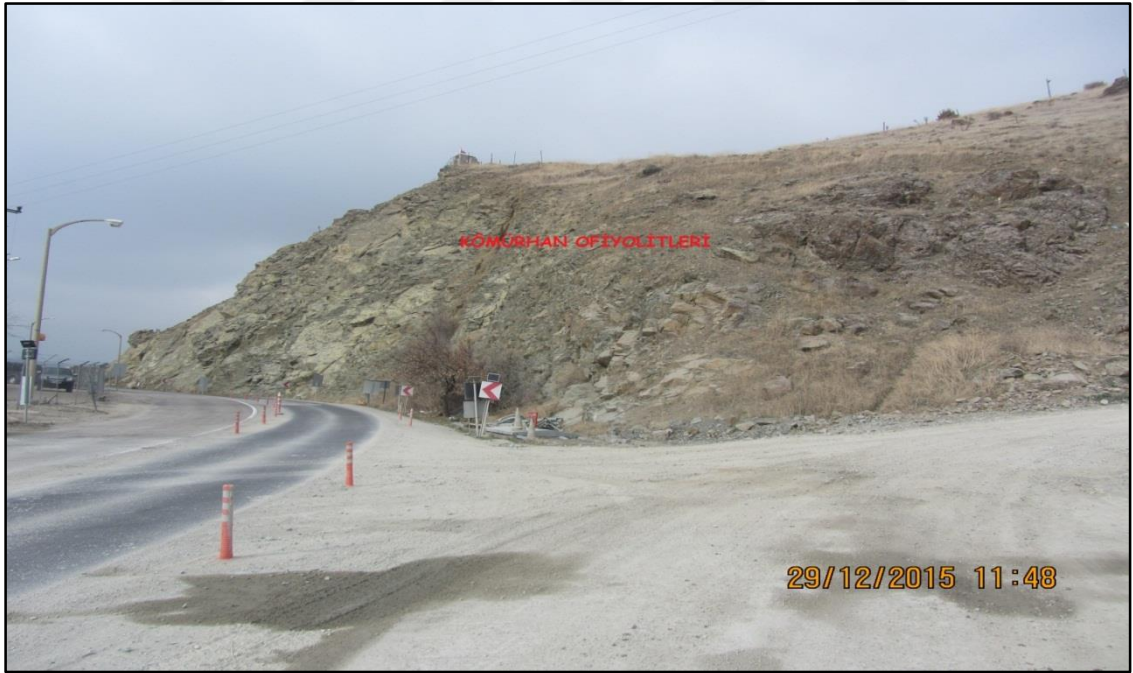
Resim 3.1. Km:0+000'dan genel görünüm
