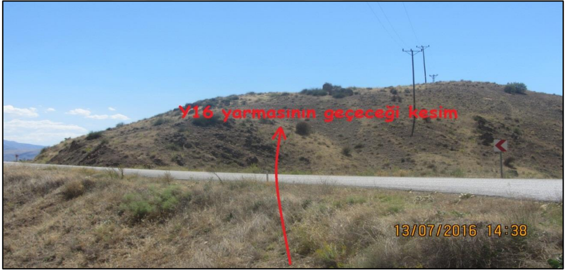
Resim 3.31. Km:6+720-6+970 arası genel görünüm
