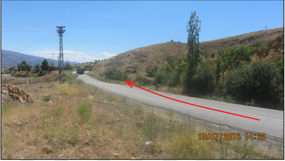
Resim 3.23. Km:5+390-5+440 arası genel görünüm.
