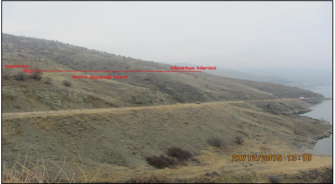
Resim 3.3. Km:0+000-1+470 de proje güzergâhının geçeceği kesimden genel görünüm.
