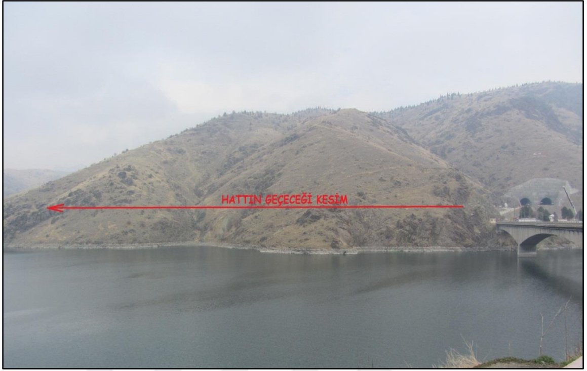
Resim 3.2. Km:0+000-1+470 de yeni hattın geçeceği kesimden genel görünüm
