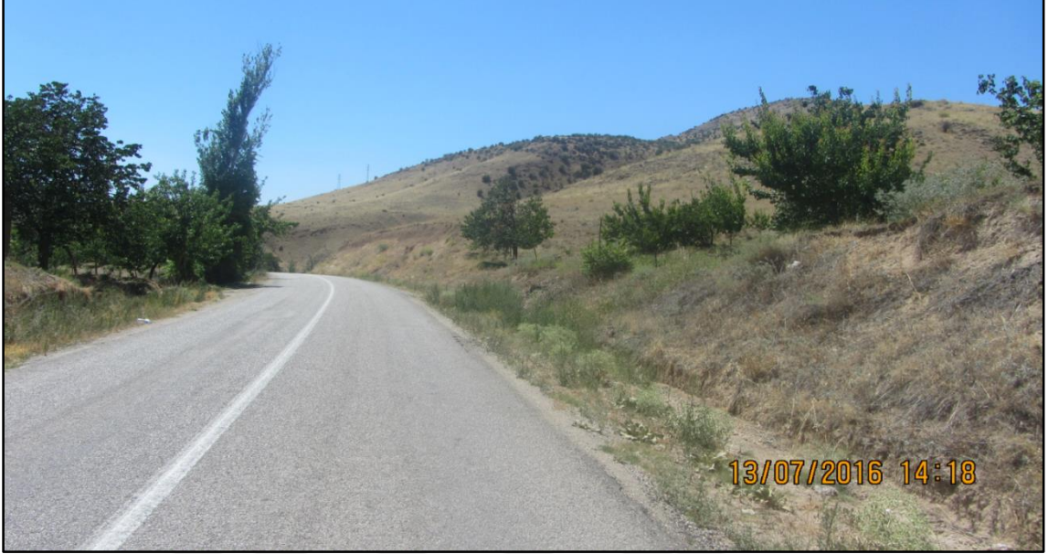
Resim 3.21. Km:5+130-5+290 arası genel görünüm
