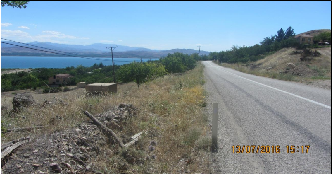
Resim 3.38. Km:9+950-10+300 arası genel görünüm.
