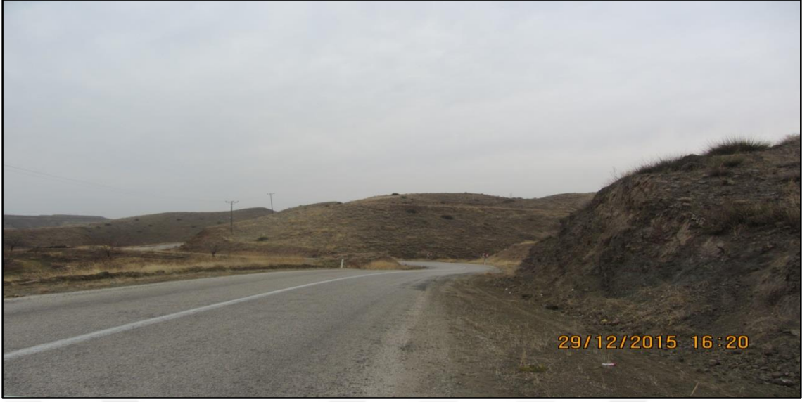
Resim 3.33. Km:6+970-8+330 arası genel görünüm.
