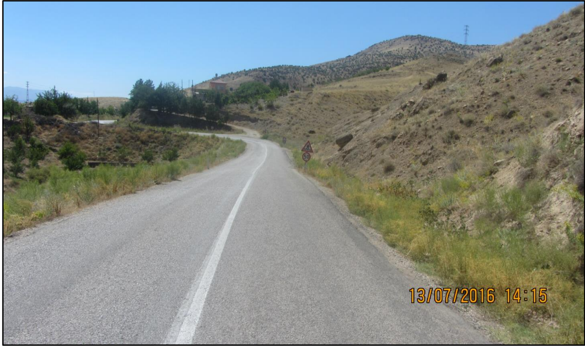
Resim 3.19. Km:4+965-5+130 arası genel görünüm.
