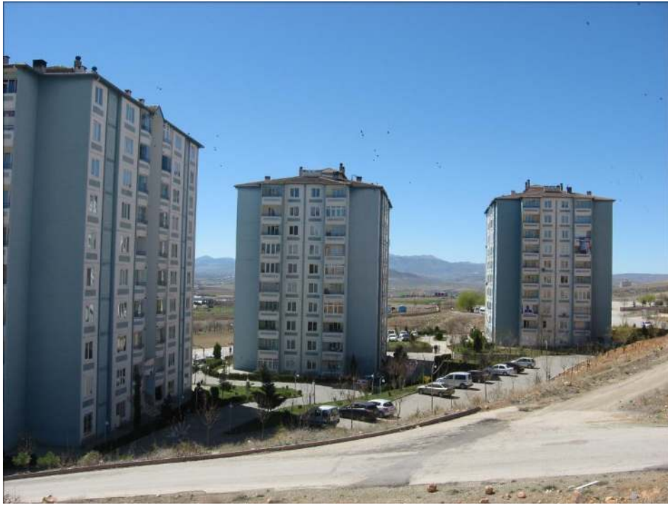
Foto 8. Elazığ Hilalkent mahallesinde oluşan basamaklar
