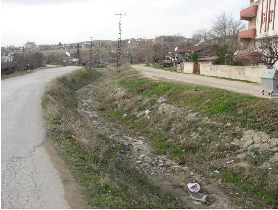
Foto 9. Elazığ Kenti kuşaklama kanalı
