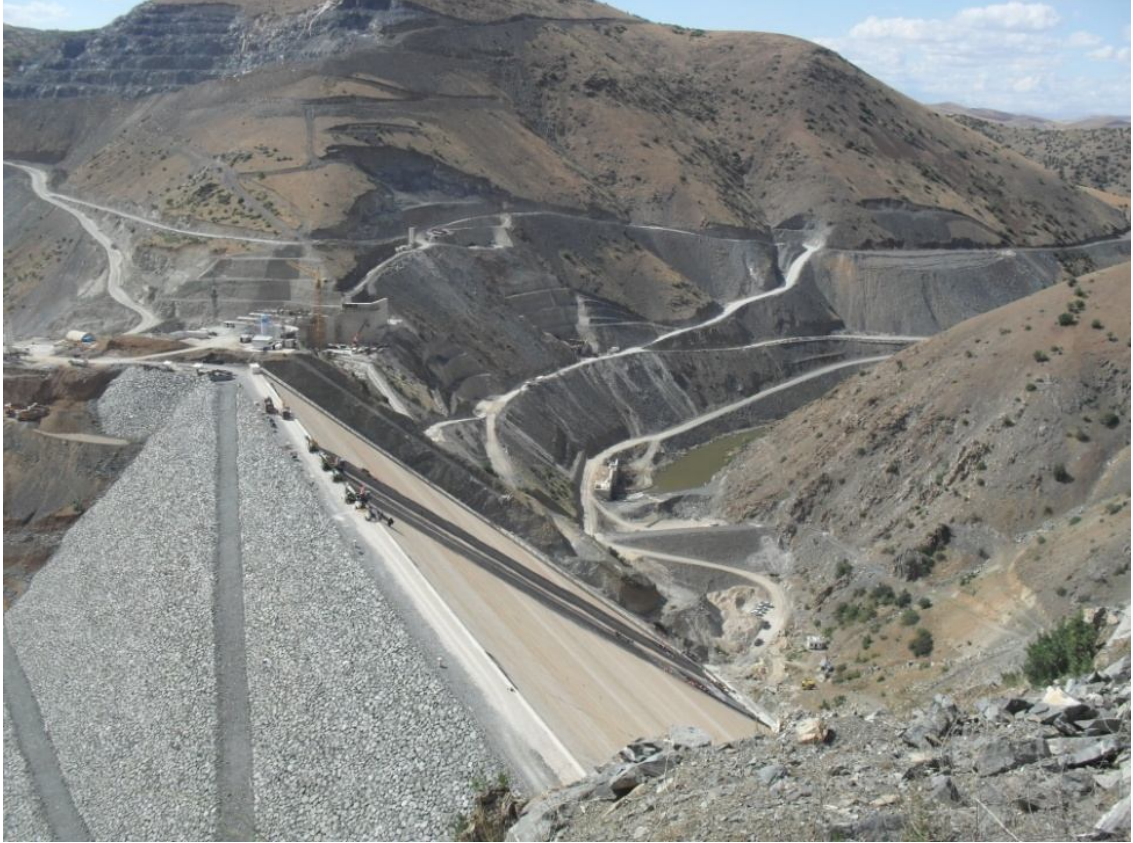
Foto 54. Ceyhan Nehri üzerinde yer alan Kandil Barajı inşaatı (2012).
