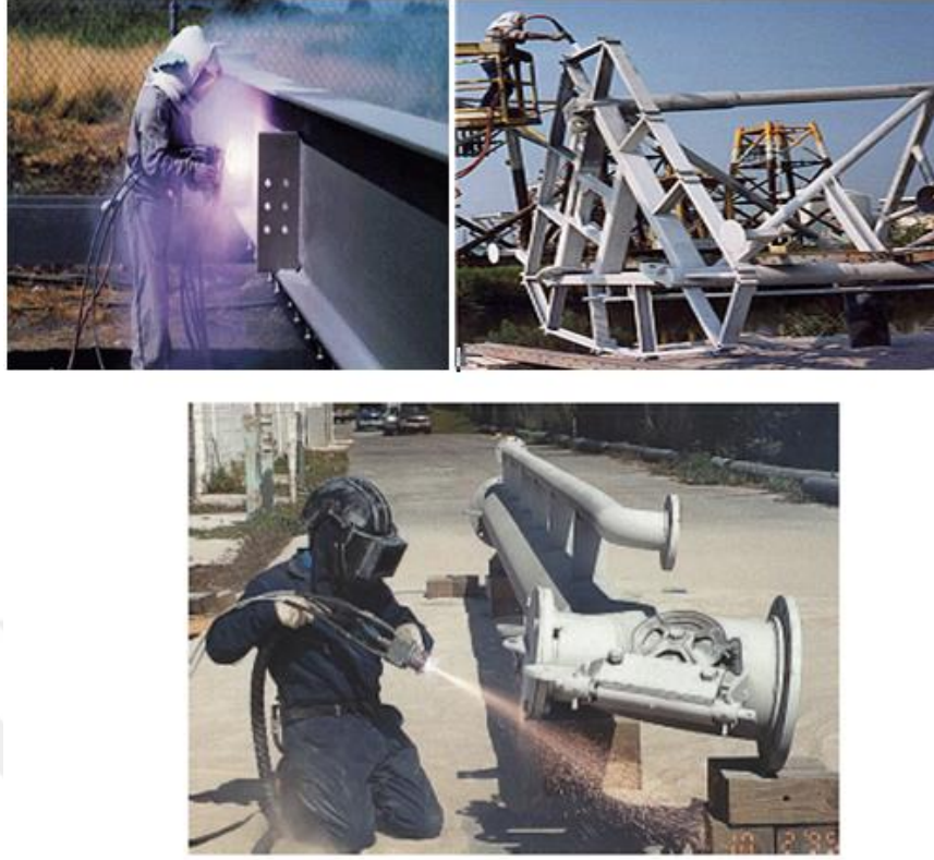
Şekil 3.6. Korozyona karşı kaplama uygulamaları [35].
