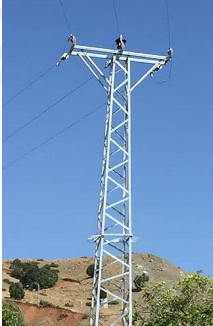
Şekil 4.2 Orta Gerilim Durdurucu Demir Direk
