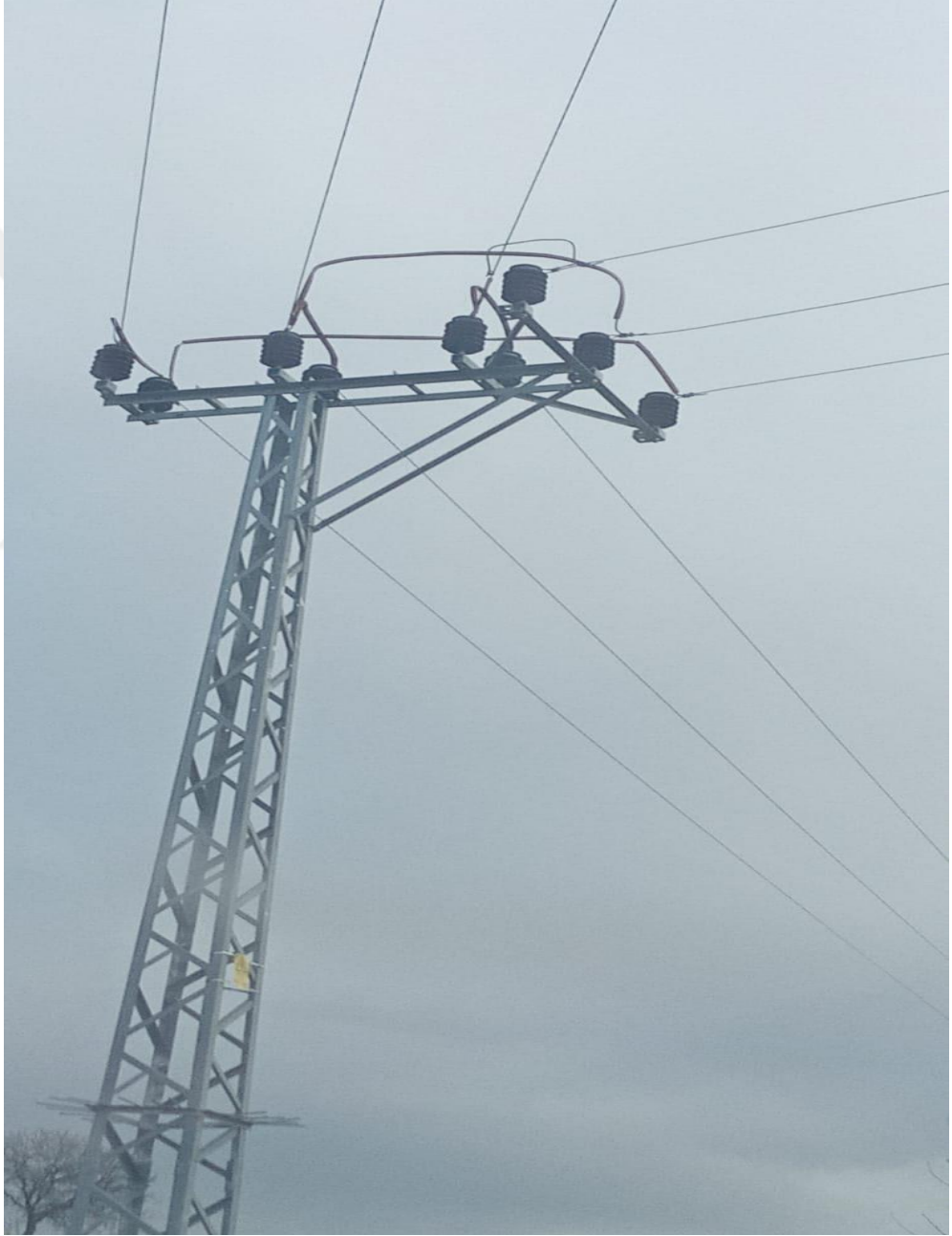
Şekil 4.3 Müşterek Durdurucu Demir Direk
