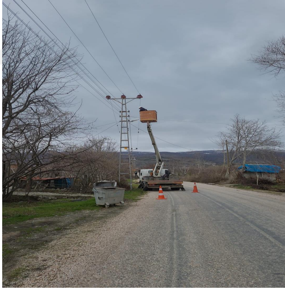
Şekil 4.1 Müşterek Taşıyıcı Direk
