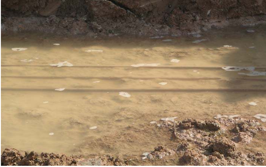
Resim 5.2. Arızanın en fazla görüldüğü kablo arızası
