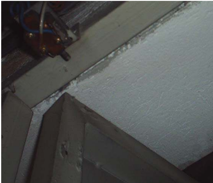
Resim 5.7. Bina giriş kapısı uyarı anahtarı
