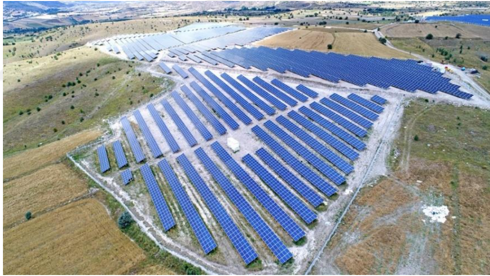
Şekil 7.3 Kurşunlu 0,86 MW GES sahası
