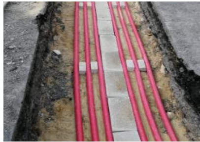
Şekil 3. 4 XLPE kablo yeraltı hat döşemesi.
