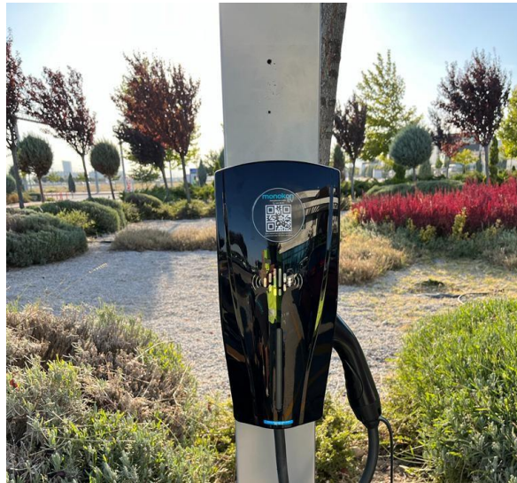
Şekil 4.9. 22 kW AC tip 2 soketli şarj istasyonu montaj görseli
