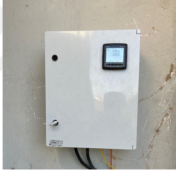
Şekil 4.6. Elektrikli araç şarj istasyonu panosu montaj görseli
