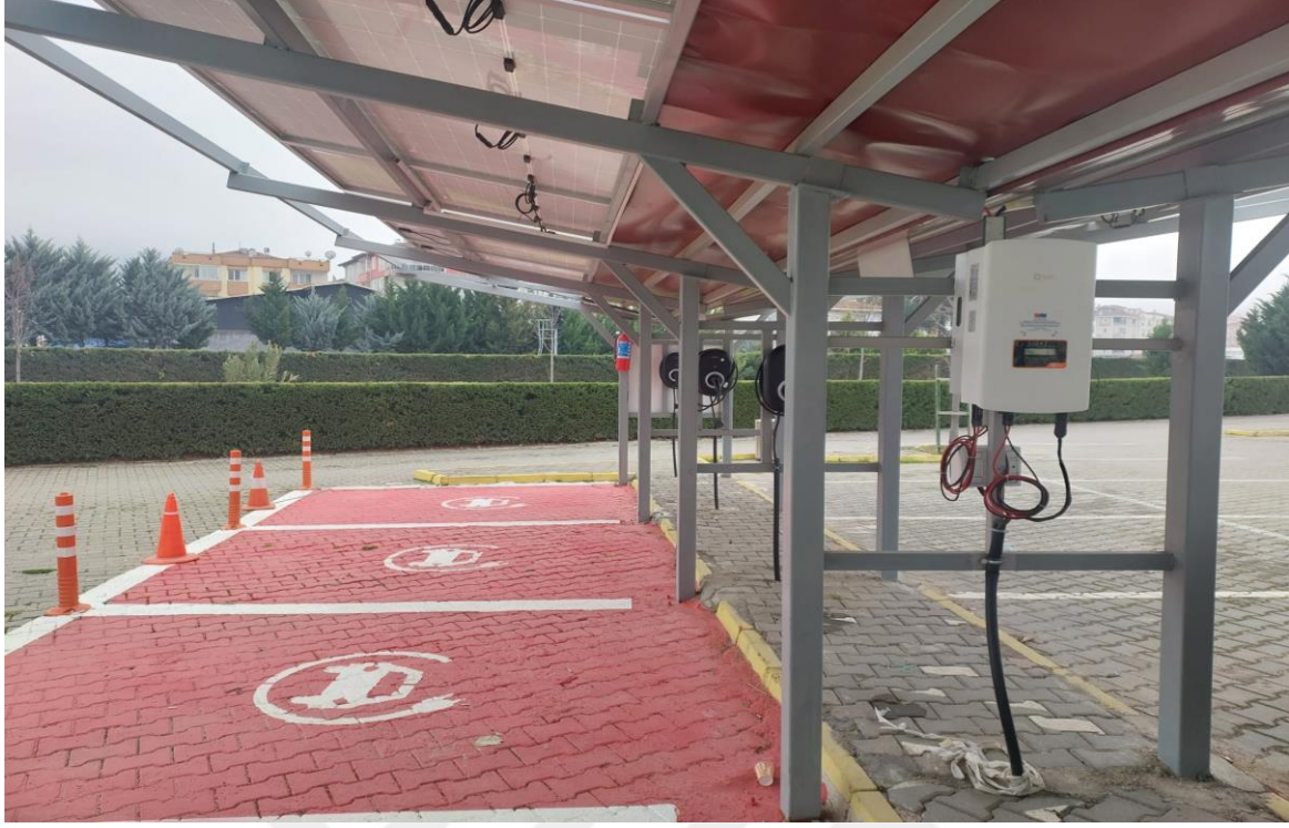
Resim 8.1. Örnek İstasyon İncelemesi
