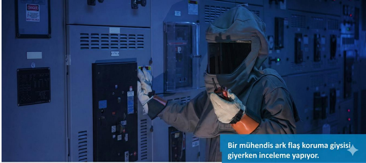
Resim 3.3. Ark flaşı tehlike kaynakları ve koruyucu ekipman gereklilikleri.
