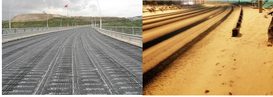
Resim 2.3 Esenboğa - Ankara yolundaki kablolu buzlanma önleyici sistem (İnt. Kyn.2).
