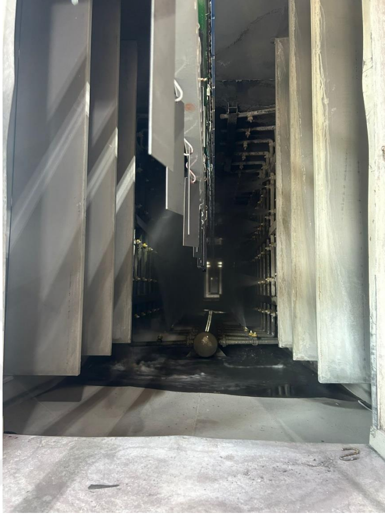
Şekil 4.5: Demir fosfat uygulaması
