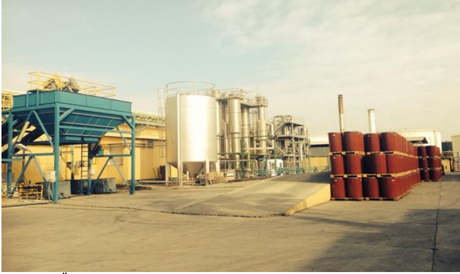
Şekil 3.1. Örnek temin edilen fabrikadan genel görünüm
