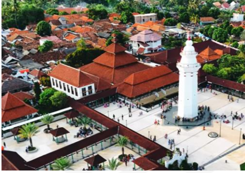
Ahşap yapı üzerinde üç katlı geleneksel "tumpang" çatı,
