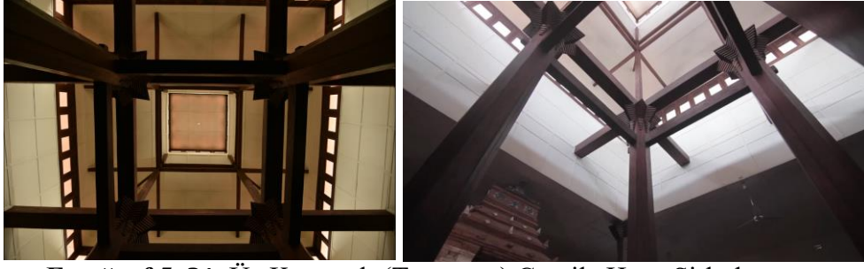
Fotoğraf 5. 31. Üç Katmanlı (Tumpang) Çatı ile Hava Sirkülasyonu
