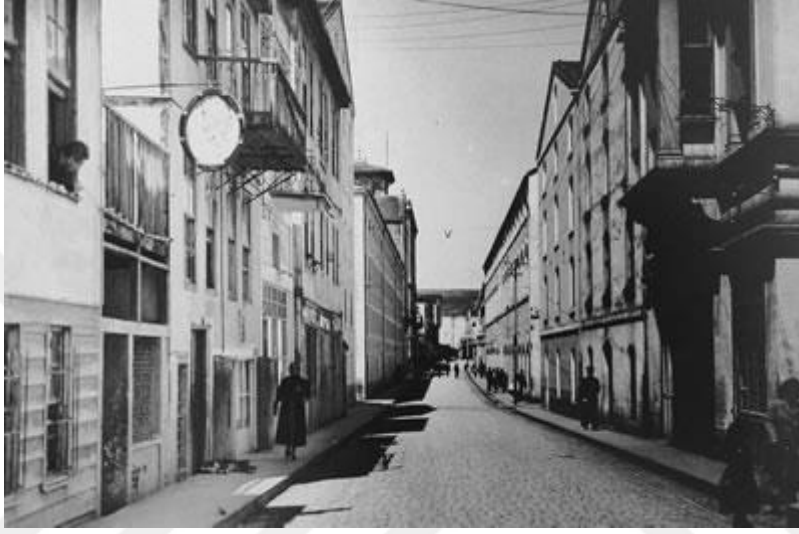
Şekil 3.16. Samsun Tütün Fabrikası görünümü (Kurt, 2014).
