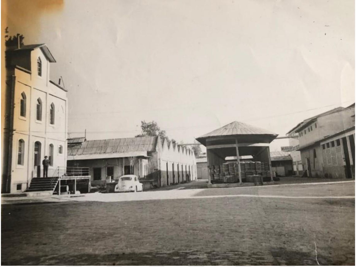
Şekil 4.5. Adana Cumhuriyet Un Fabrikası'nın yapıldığı dönemden bir fotoğraf. (Ramazan Atıl Arşivinden)
