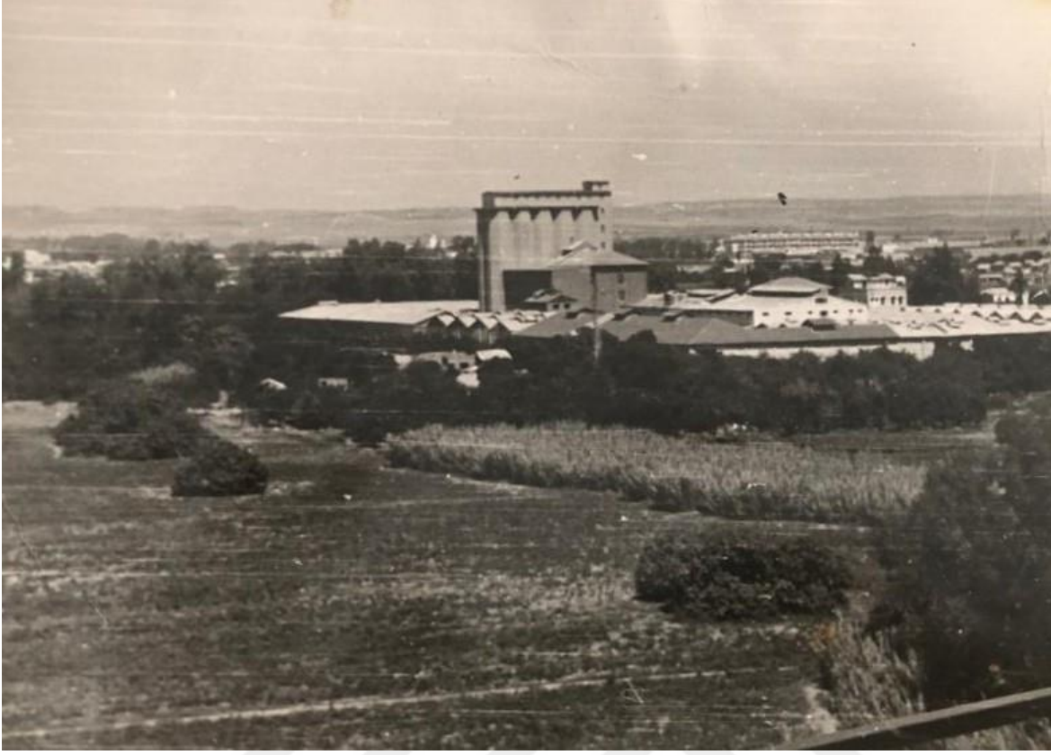
Şekil 4.4. Adana Cumhuriyet Un Fabrikası'nın yapıldığı dönemden bir fotoğraf. (Ramazan Atıl Arşivinden)
