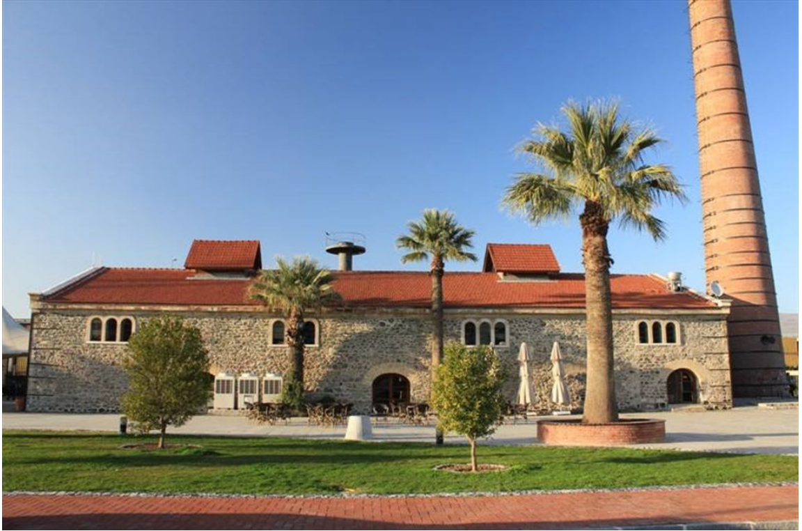
Şekil 5.43. İzmir Havagazı Fabrikası, restorasyon sonrası hali [73].
