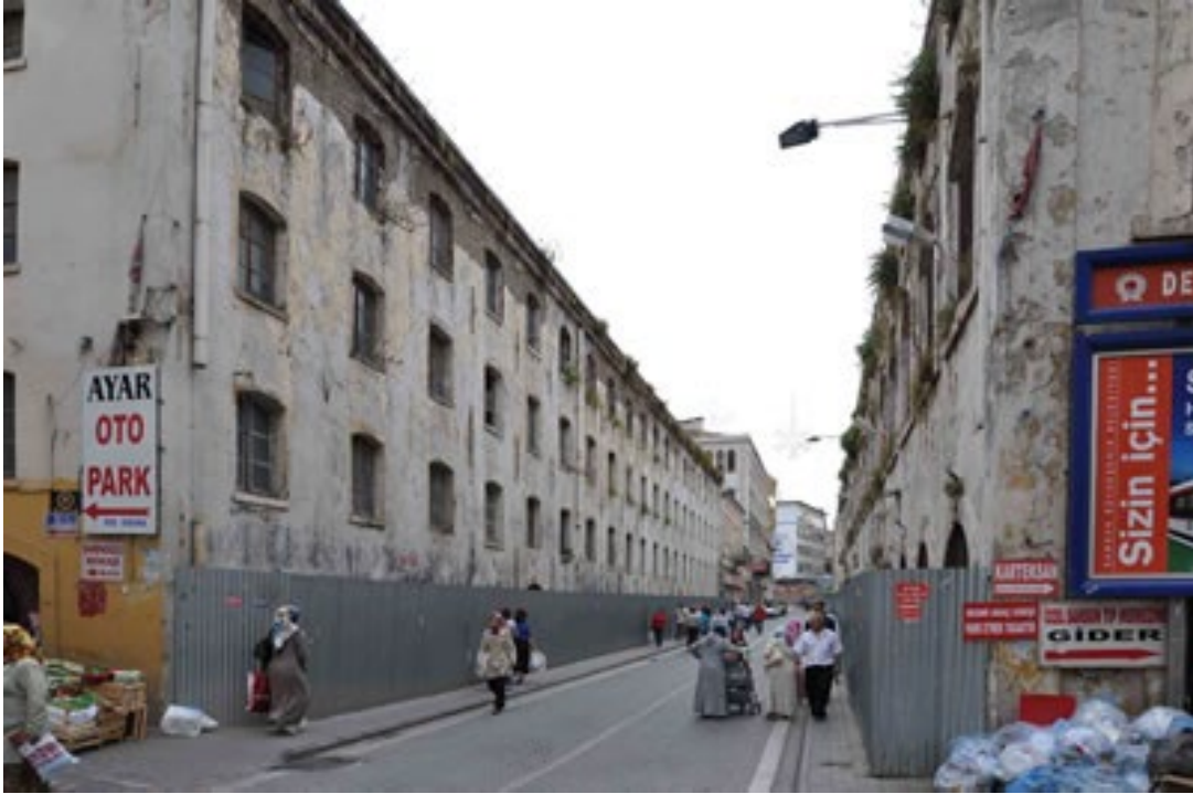
Şekil 5.24. Samsun Tekel Tütün Fabrikası restorasyon öncesi [54]
