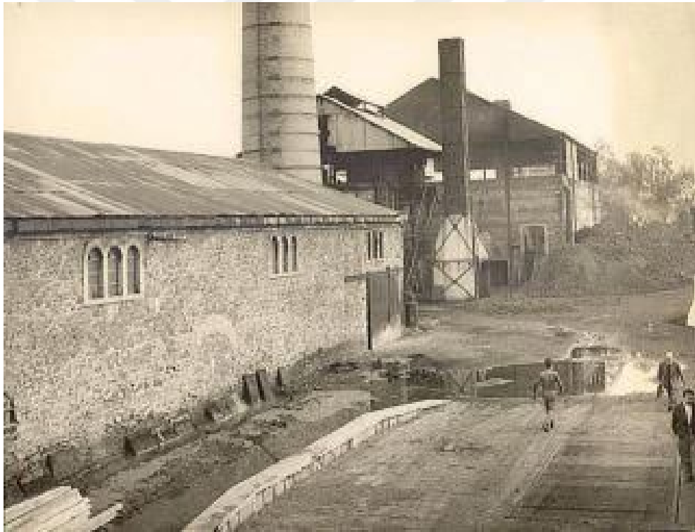
Şekil 5.42. İzmir Havagazı Fabrikası eski fotoğrafı [72].
