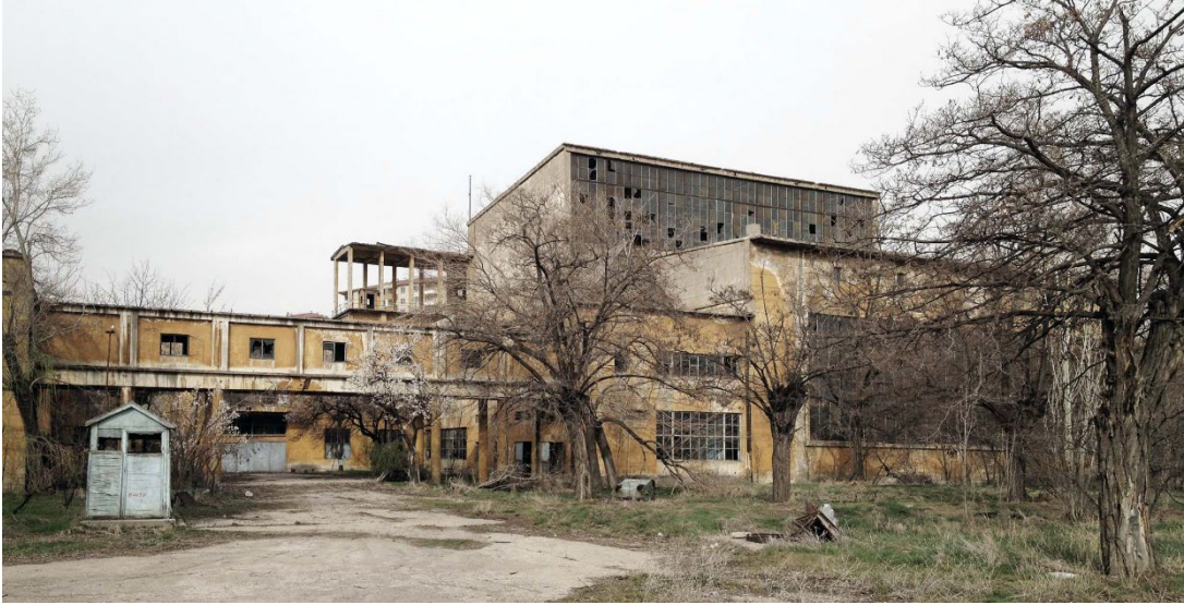
Şekil 5.49. Kayseri Sümerbank Beş Fabrikası, restorasyon öncesi
