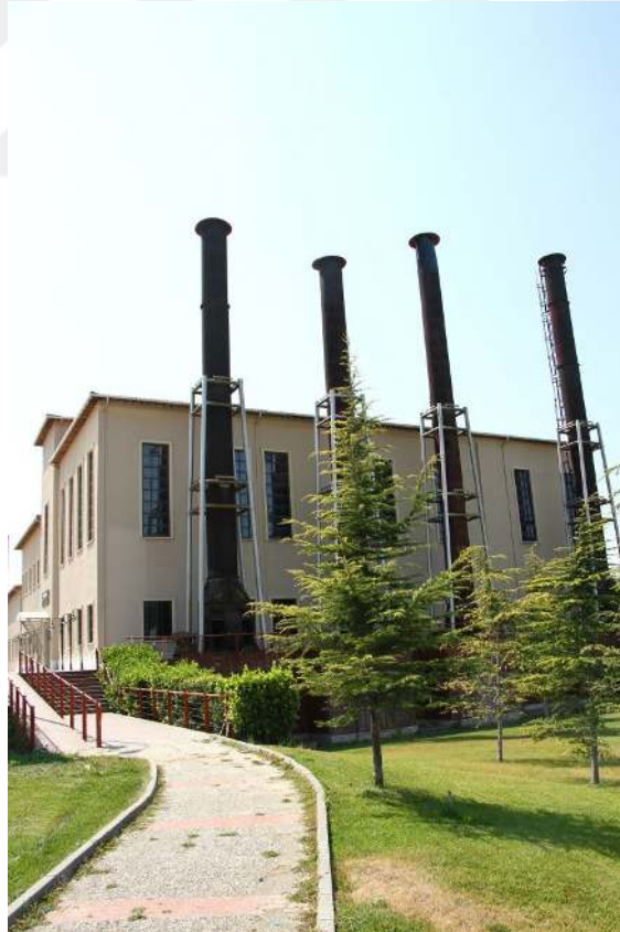
Şekil 5.28. Bursa Merinos Yünlü Dokuma Fabrikası, restorasyon sonrası [59]
