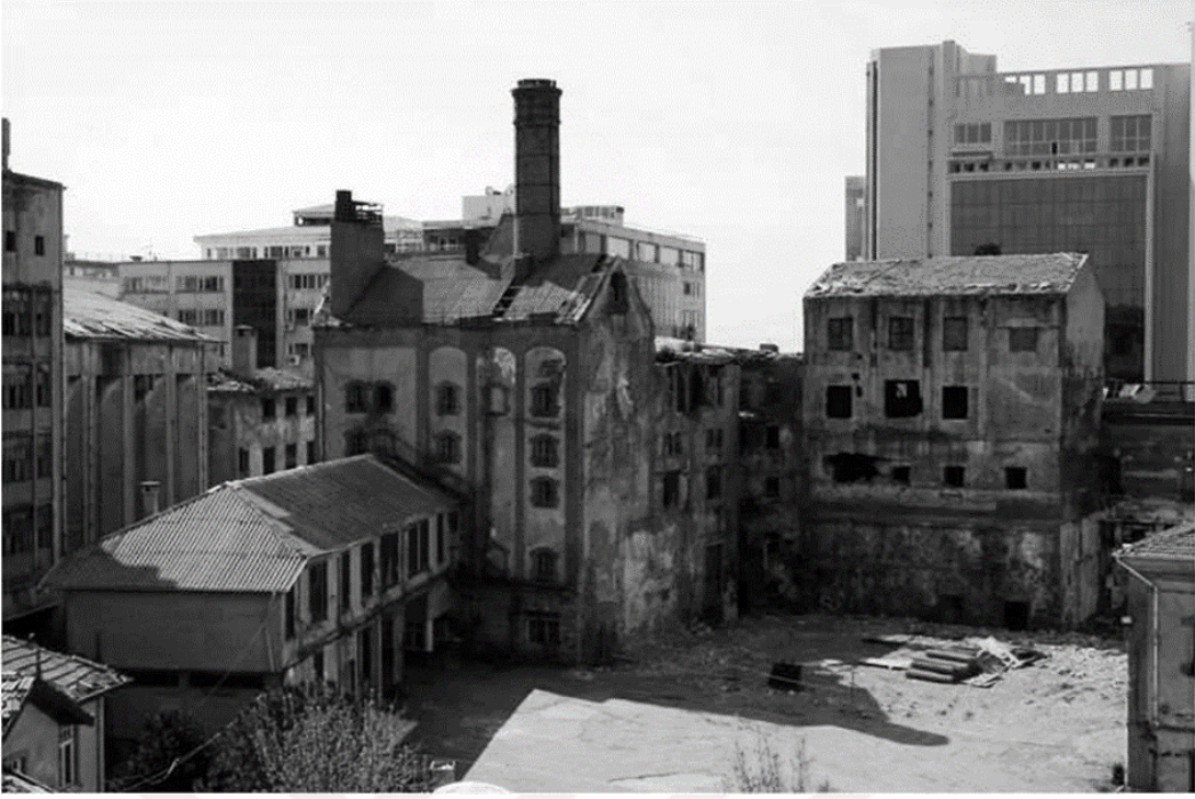
Şekil 5.15. Bomonti Bira Fabrikası restorasyon öncesi [50]
