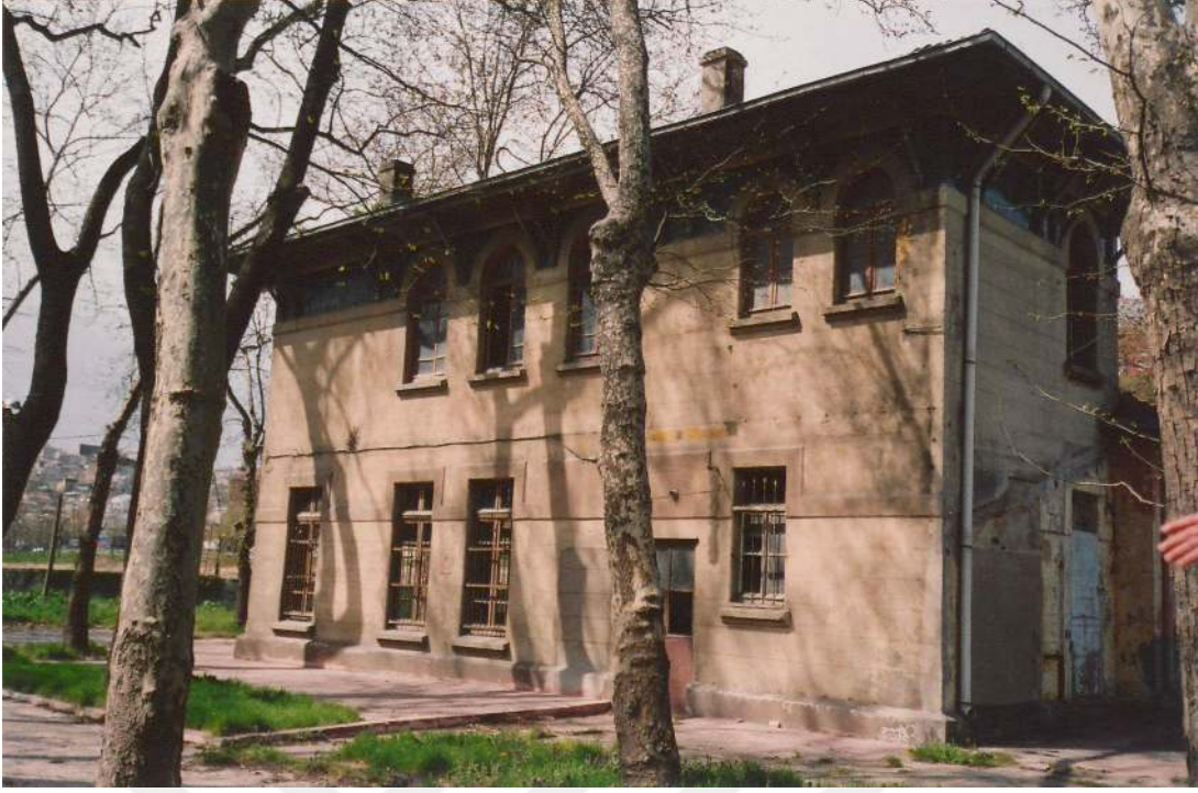
Şekil 5.61. Silahtarğa Elektrik Santrali restorasyon öncesi [91]
