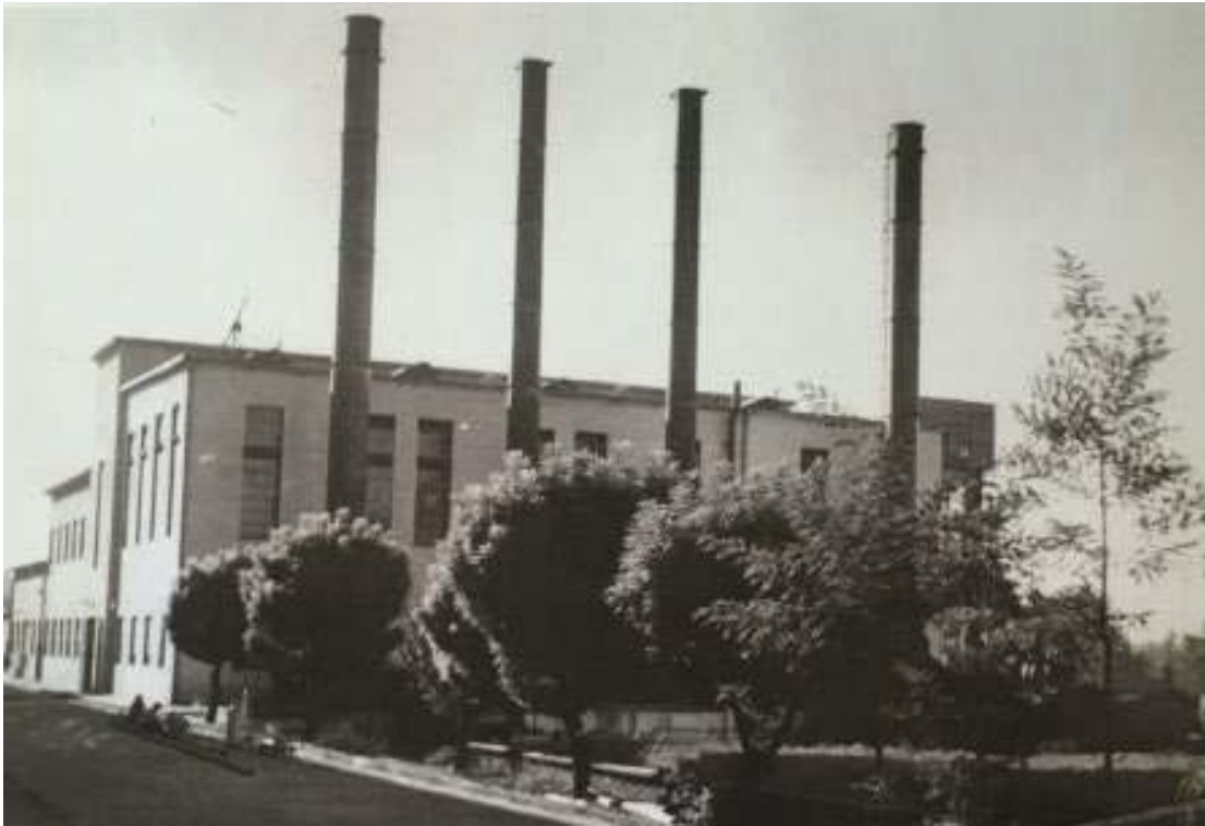
Şekil 5.25. Bursa Merinos Yünlü Dokuma Fabrikası [57]
