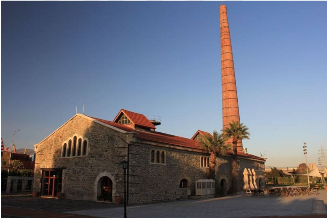
Şekil 5.44. İzmir Havagazı Fabrikası, restorasyon sonrası hali [73].
