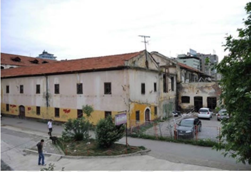
Şekil 5.23. Samsun Tekel Tütün Fabrikası restorasyon öncesi [54]
