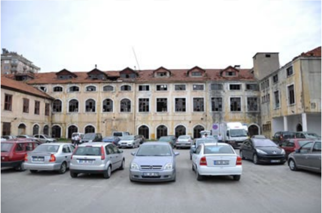
Şekil 5.22. Samsun Tekel Tütün Fabrikası restorasyon öncesi [54]
