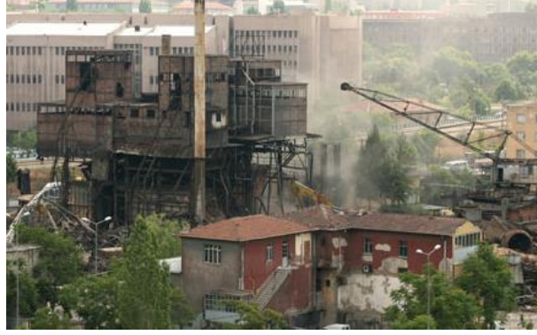
Şekil 2.12 : Ankara Elektirk Havagazı ve Otobüs İşletmesi Müdürlüğü bahçesindeki tarihi hava gazı fabrikası ve elektrik santralinin bazı önemli binalarının yıkımı, 2006 (Url-7).
