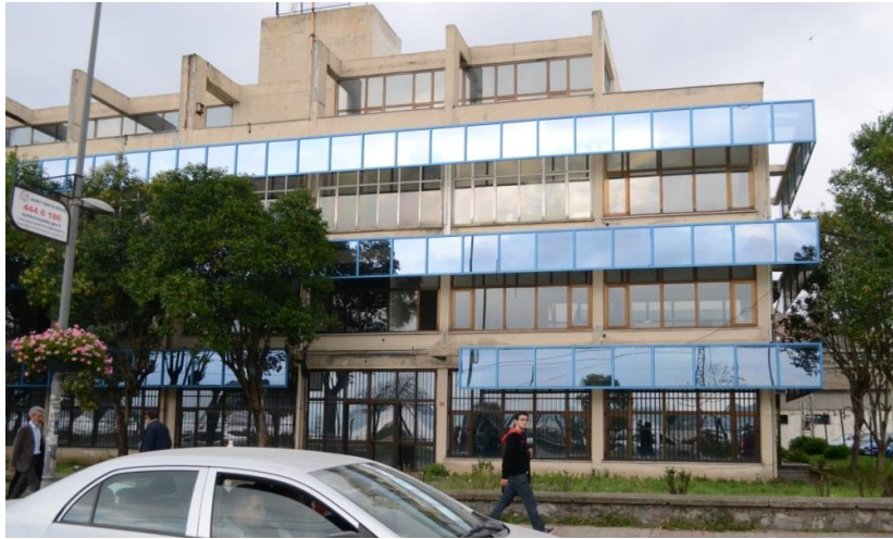
Şekil 4.24 : Paşabahçe Şişecam Fabrikası Yönetim Binası (Özdemir, 2015).
