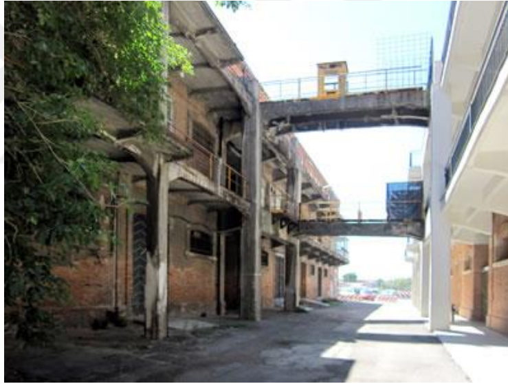
Şekil 4.39 Yenilenen derslikler ve yapının yenilenmemiş kısmından bir görsel
