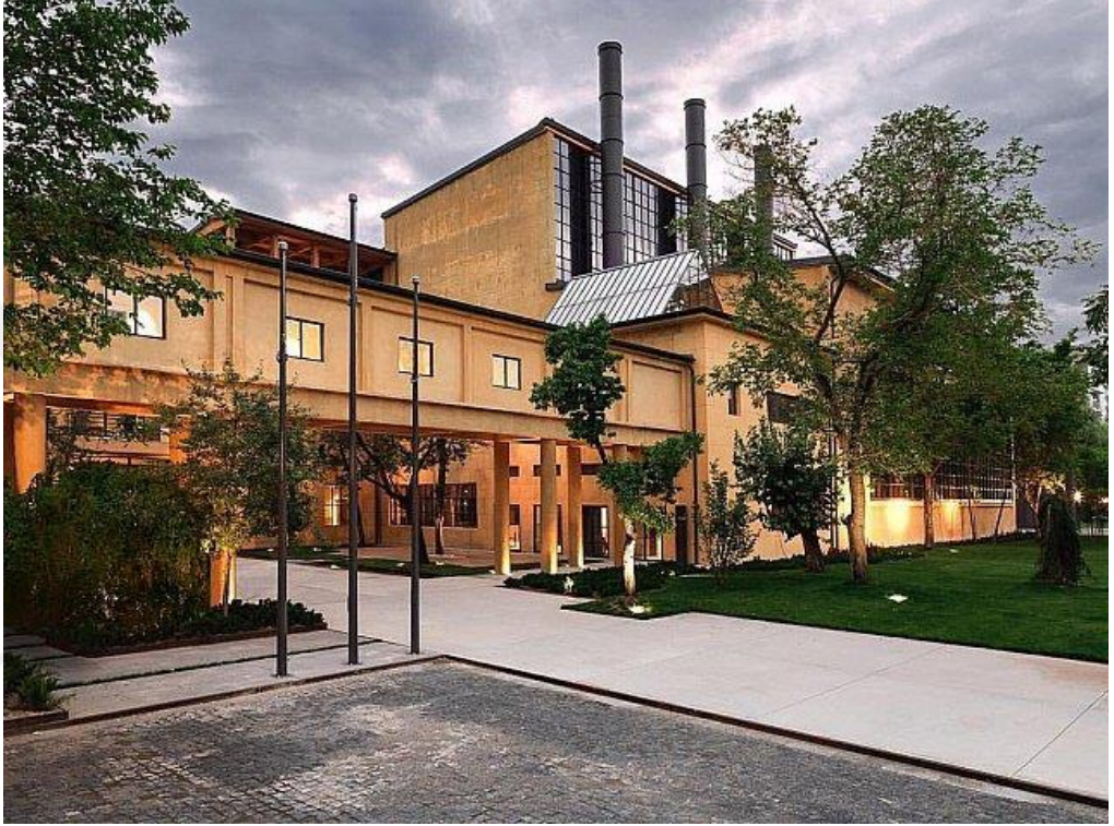
Şekil 4.14 Kayseri Sümerbank Beş Fabrikası yenilenmiş hali
