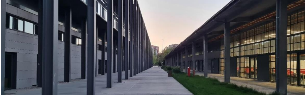
Şekil 4.18 Abdullah Gül Üniversitesi çelik bina ve ambar binasının arasında bulunan yaya yolu
