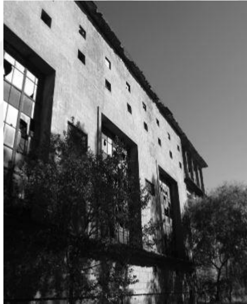
Şekil 4.11 Kayseri Sümerbank Beş Fabrikası
