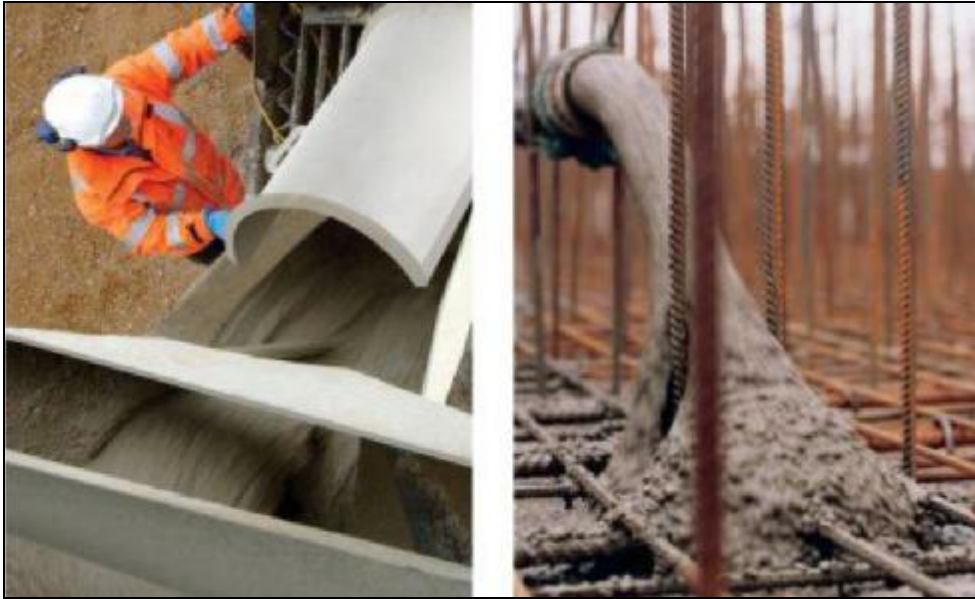
Şekil 3.2. Kendiliğinden yerleşen beton uygulamaları (MEGEP, 2012)
