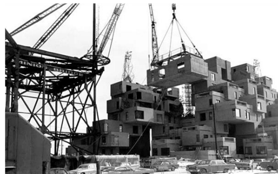
Şekil 4.25. Habitat 67 Genel Görünüm ve Montaj Aşaması Safdie Architects (URL 42)
