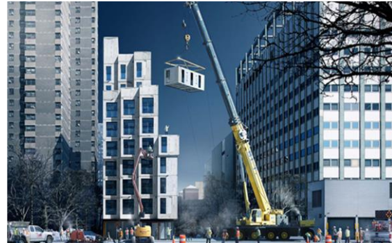
Şekil 4.19. Prefabrike Hücre Sistem İle Üretilen Yapı Örneği Üretim ve Montaj Aşamaları Carmel Place - nARCHITECTS (URL 32)
