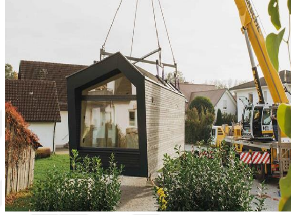
Şekil 4.81. Cabin One Marka Endüstriyel Barınma Nesnesi Marka Logosu, Örnek Model Görselleri, Yapım ve Nakliye Süreci (URL 140)
