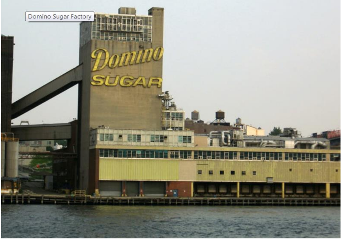
Şekil 27: Domino Şeker Fabrikası Eski Görünüşü
