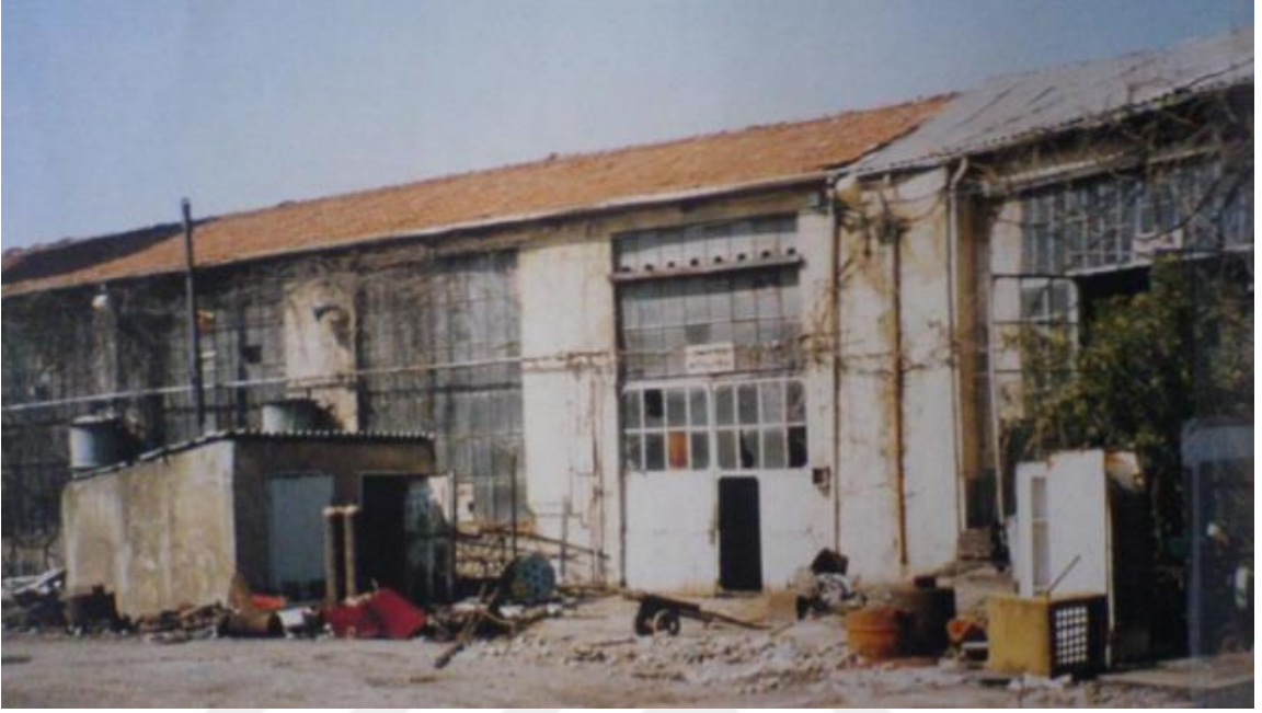
Şekil 61: Hasköy Tersanesi Restorasyon Öncesi Görünüşü
