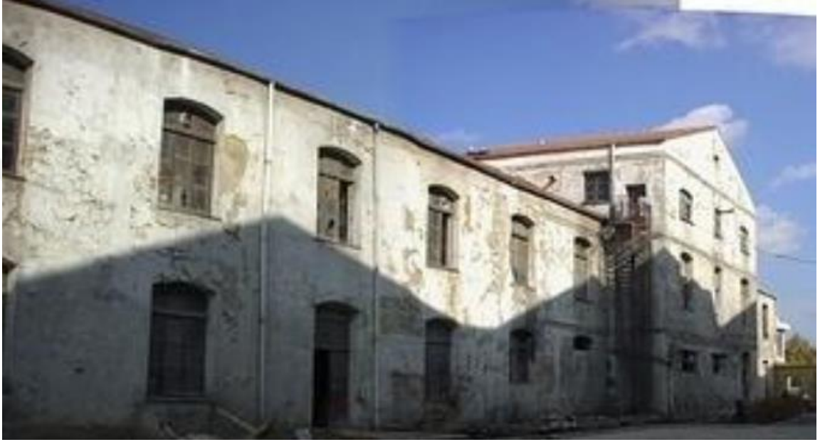
Şekil 102: Restorasyondan Önce Cibali Tütün Fabrikası
