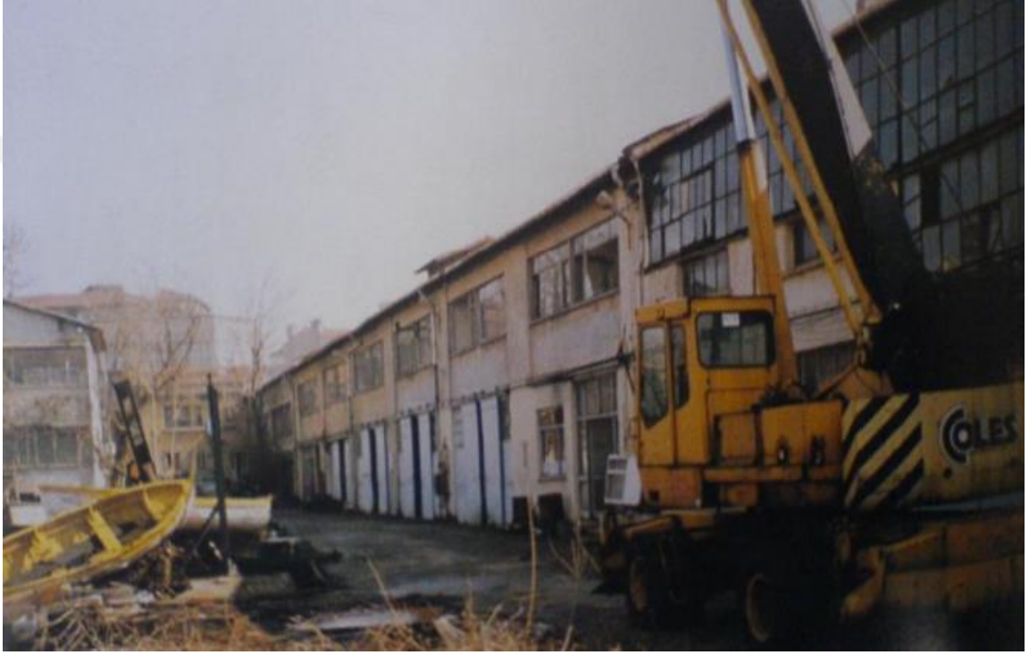
Şekil 60: Hasköy Tersanesi Restorasyon Öncesi Görünüşü
