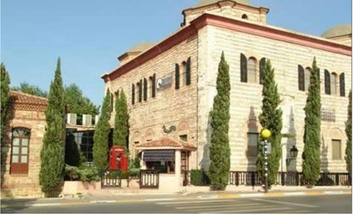
Şekil 59: Lengerhane Binası Restorasyon Sonrası
