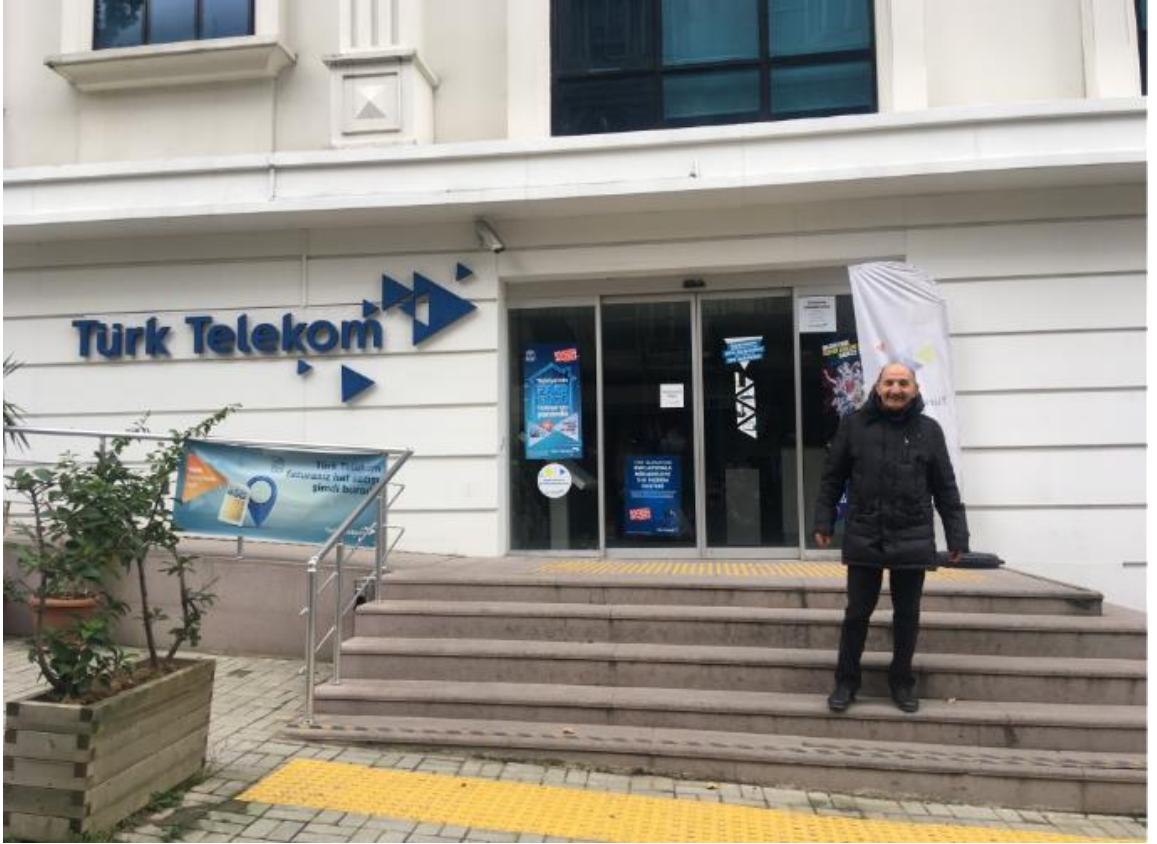
Şekil 109: Yenilenmiş Santral Binası
