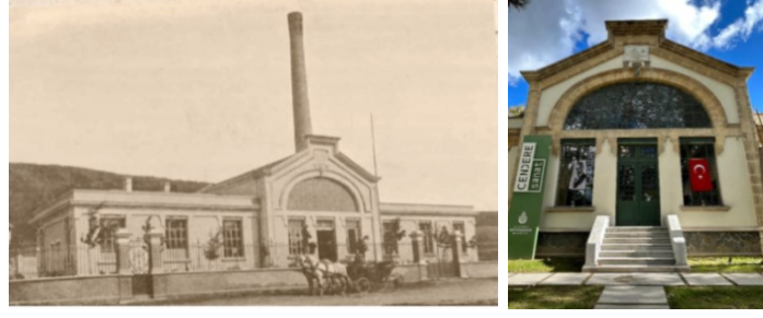
Şekil 3.16. Cendere Pompa İstasyonu (Uğuryol, 2020, s.431) ve Günümüzde Cendere Sanat Ana Binası (Bozkurt, 2024, s.103)
