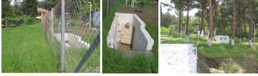
Şekil 5.31. Ayvaz Su Kaynağı Kaptaj Alanı (Danişmend Hüseyin Şahin Arşivi; Niksar Belediyesi Arşivi)
