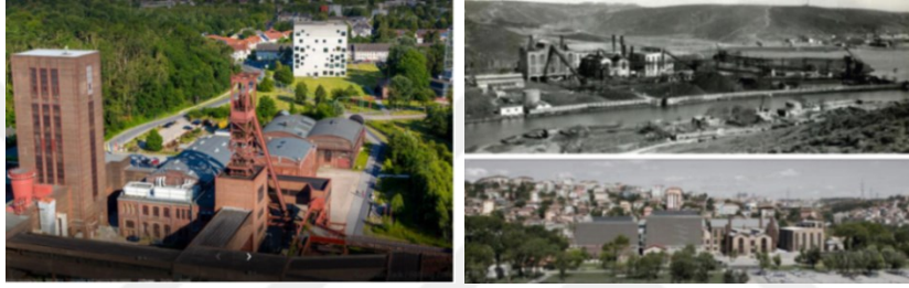
Şekil 2.16. Sırasıyla Zeche Zollverein Yerleşkesi (Ergenç, 2019, s.50) ve Öncesi Silahtarağa Elektrik Santrali ve Sonrası Santral İstanbul (Kavut ve Selçuk, 2022, s.206)
