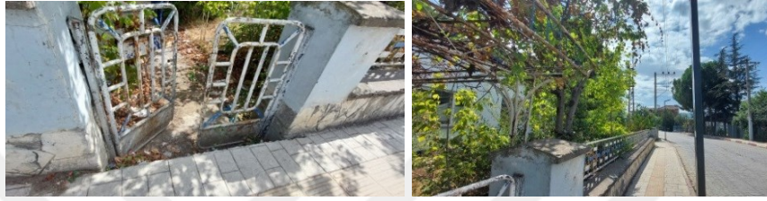
Şekil 5.59. İşletme Yerleşkesinin Bahçe Kapısı ve Bahçe Duvarı (Yazar Arşivi, 2023)
