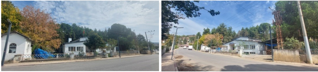
řekil 5.47. Niksar Ayvaz Memba Suyu İşletmesinin Batı Cephesinden Silüet Görünümü Görseli (Yazar Arřivi, 2024)
