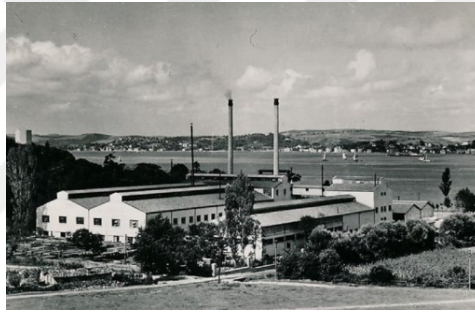
Şekil 2.8. Paşabahçe Cam Fabrikası (Aydın ve diğerleri, 2022, s.26)
