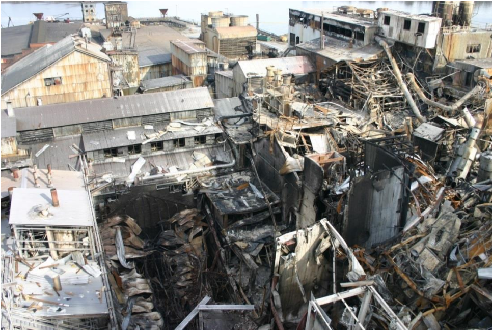
Şekil 4.1: Hayes Lemmers fabrikasının toz toplama istemlerinde NFPA 484 gerekliliklerine uyulmadığı için meydana gelen patlama.
