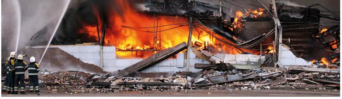
Şekil 6.10: Hayes Lemmerz patlaması sonrası çıkan yangın.
