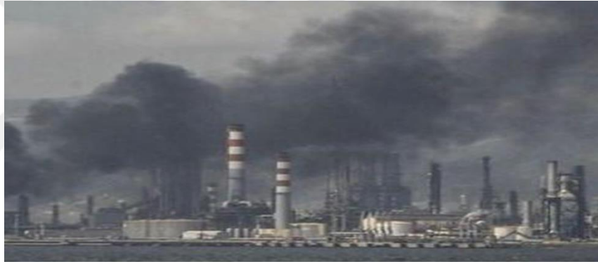
Şekil 8. Kimya rafineri patlaması
