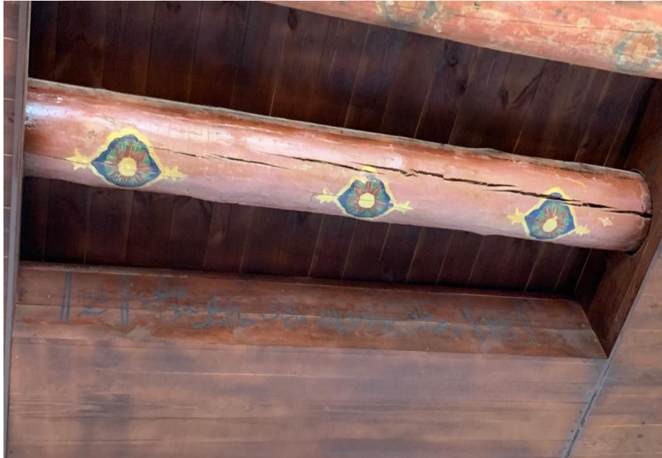
Şekil 3.5. Güneydoğu Odasında Tavan Ahşap Kirişleri Üzerindeki Sülüs Detayı
