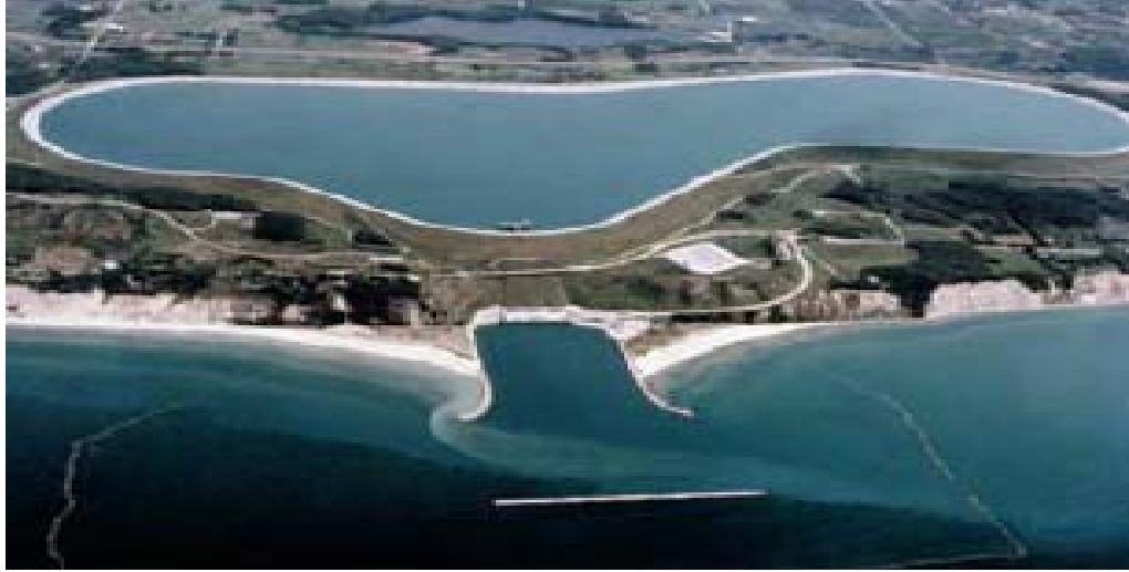
Şekil 5.3: Ludington pompajlı santralinin görünümü (Saraç, 2009).
