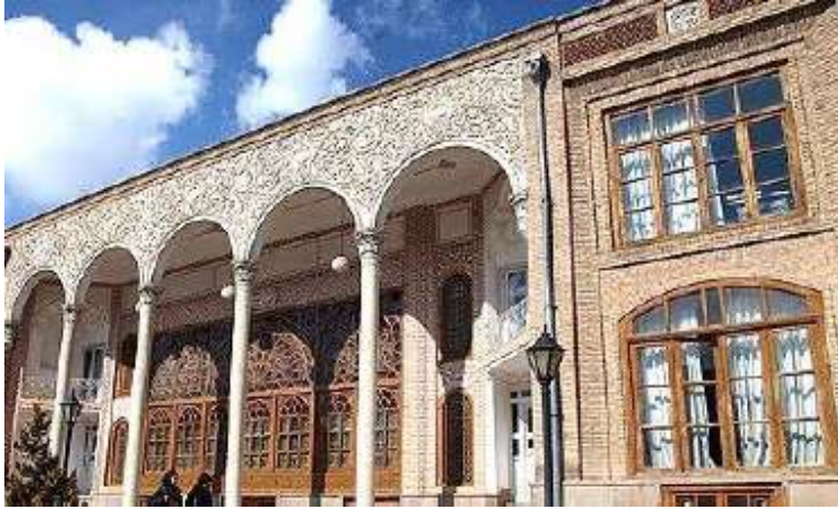
Şekil 2.21. Tuğla ve taş ile kaplanan kerpiç duvar (URL-6)
