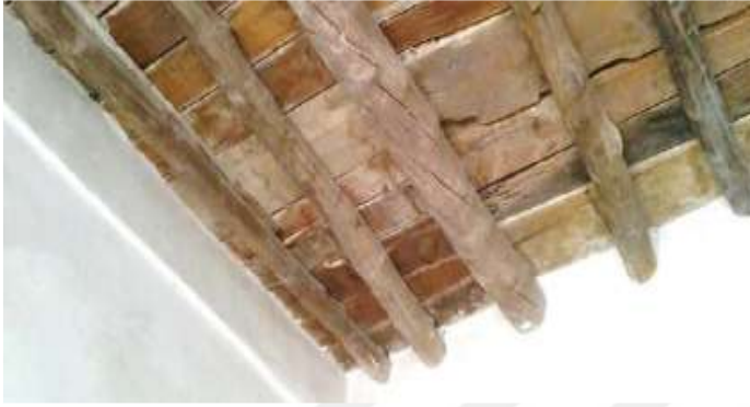
Şekil 2.20. Ahşap çatı strüktürü (URL-5)
