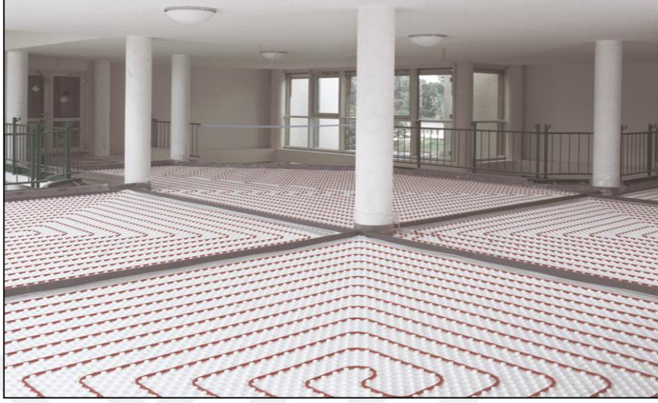
Şekil 2.26. Yerden ısıtma ve soğutma sistemi örneği [49]
