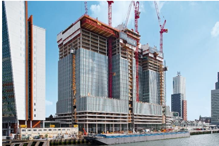
Şekil 5.16 De Rotterdam kulesi yapım aşaması (Archi, 2015)
