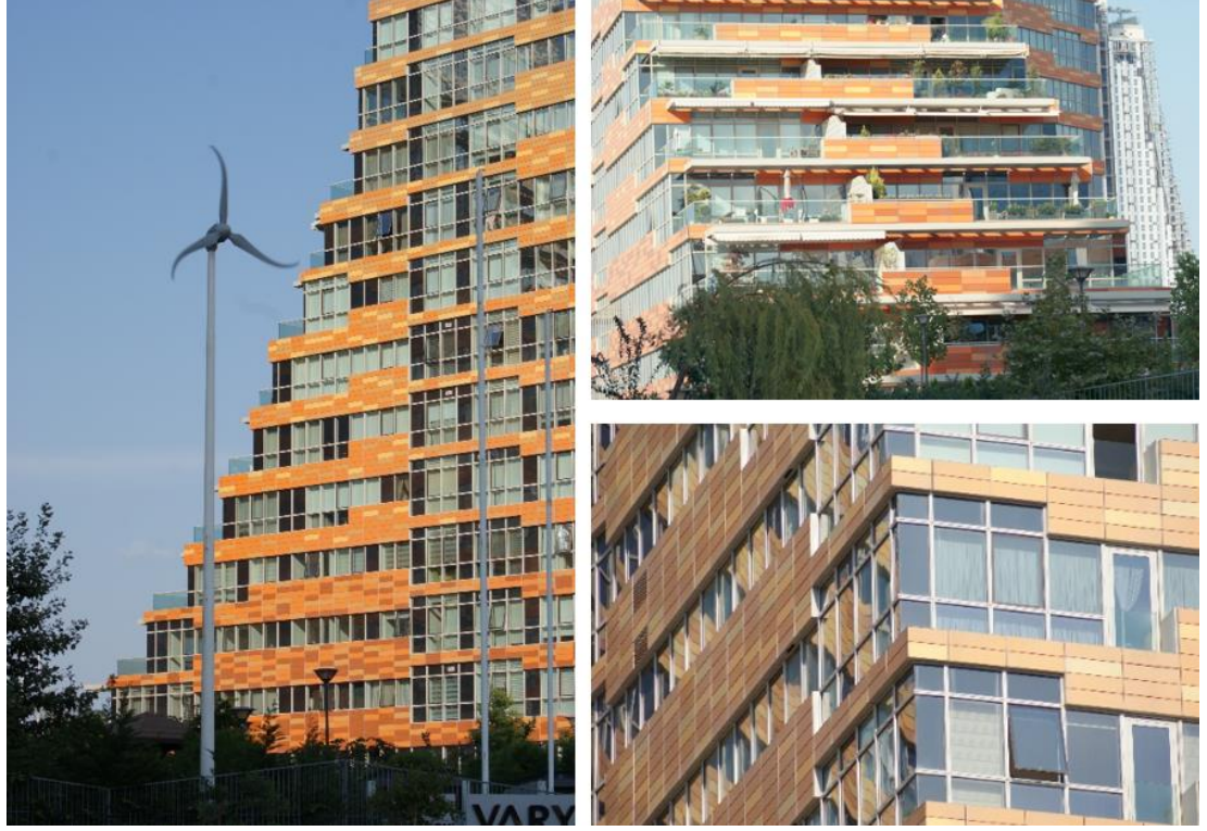
Şekil 5.25 Varyap Meridian kompleksi dış cephe aktif rüzgar elemanları
