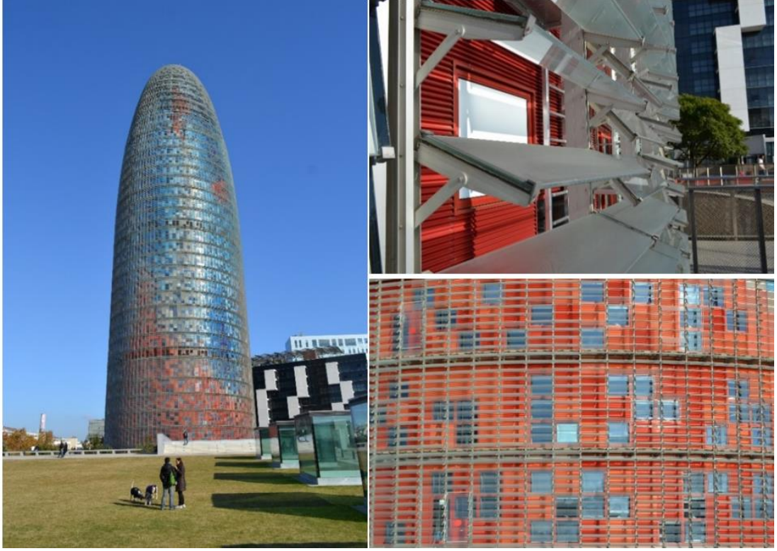
Şekil 5.9 Agbar kulesi dış görünüş ve cephe detayı
