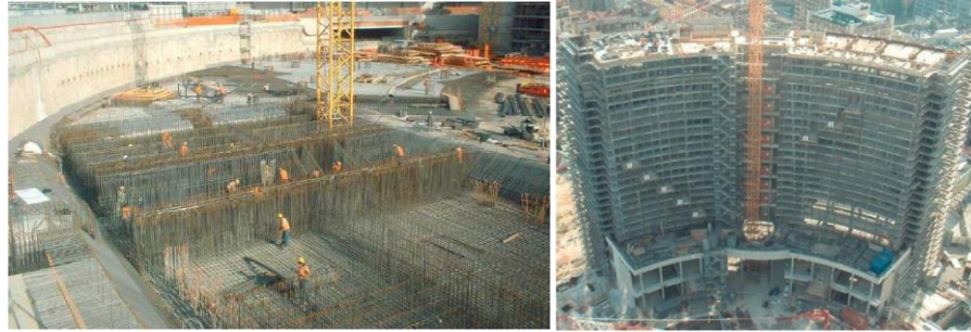
Şekil 5.12 Unicredit A Kulesi inşaat aşaması (Politecnico di Milano 2015)
