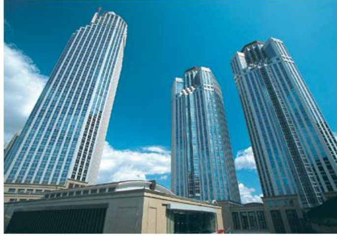
Şekil 5.34 İş Bankası kulesi I cephe görünüşü (Kırkan, 2005)
