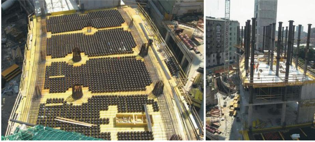
Şekil 5.4 Palazza Lombardia kulesi Milano yapım aşaması (CTBUH 2015)
