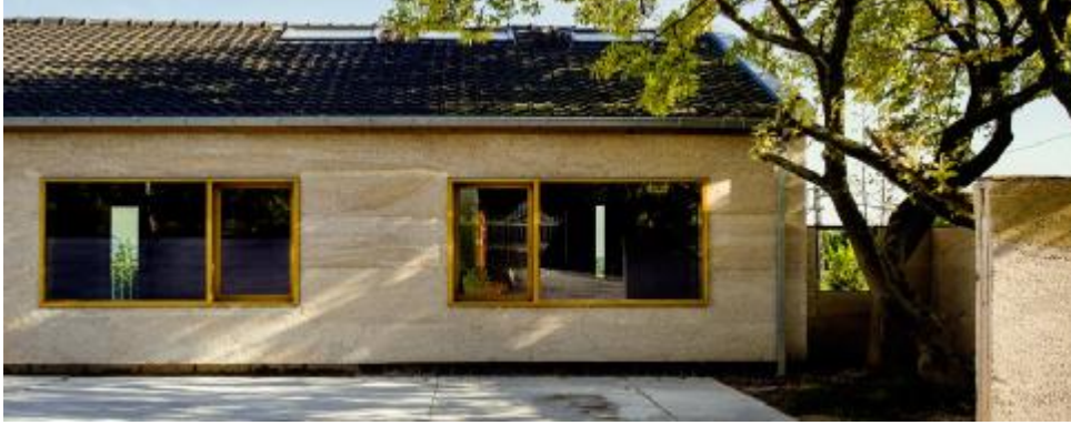
Şekil 5. 10. Energy-Neutral Bungalow Yapı Malzemesi Olarak Kullanılan Kenevir
