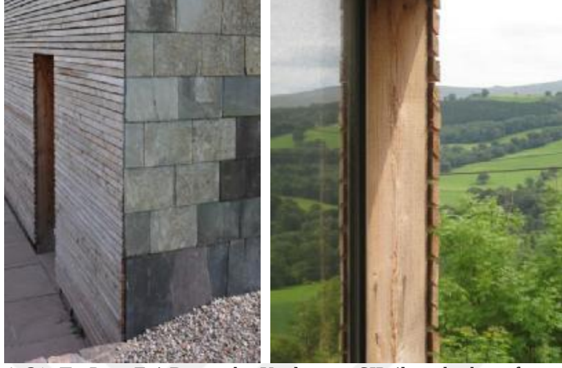
Şekil 4. 31. Ty Pren Evi Dış cephe Kaplama ve SIP ile yüksek performanslı cam birleşimi (URL-36)
