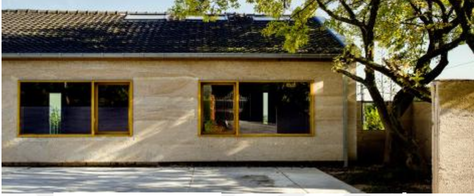
Şekil 4. 48. Energy-Neutral Bungalow Hempcrete Cephe Uygulaması (URL-48)
