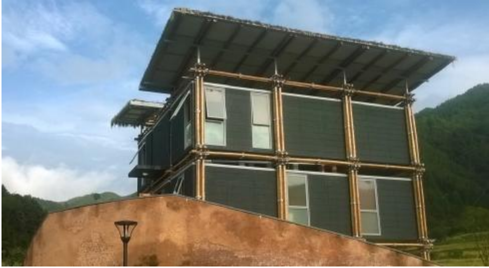
Şekil 4. 23. Enerji Verimli Bambu Ev Sırlı Panel Kaplama Cephesi (URL-32)
