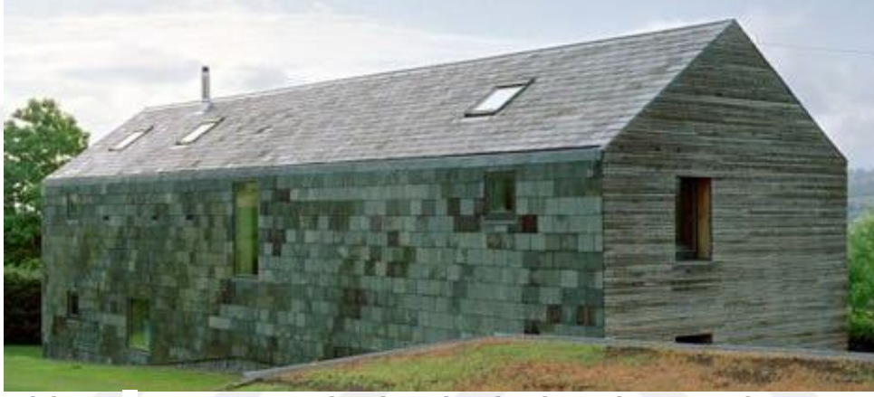
Şekil 4. 30. Ty Pren Evi Yerel Malzemeleri ile Oluşturulan Dış Cephe Görünümü (URL-36)
