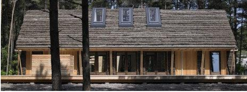
Şekil 5. 9. The Modern Seaweed House’da Yapı Malzemesi Olarak Kullanılan Yosun
