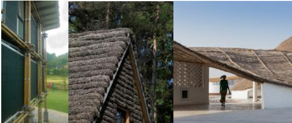
Şekil 5. 2. Enerji Verimli Bambu Evi, The Modern Seaweed House Ve Senegal Kültür Merkezi’nde Kullanılan Doğal Malzemeler
