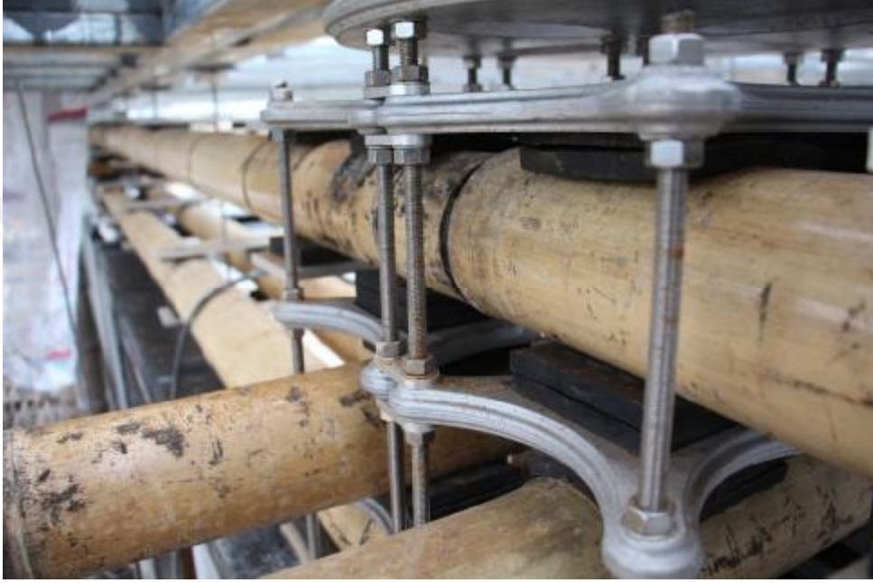
Şekil 5. 3. Enerji Verimli Bambu Evi Bambu-Çelik Birleşim Detayı
