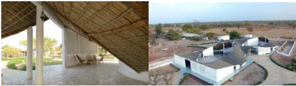
Şekil 5.1. Senegal Kültür Merkezinde Kullanılan Geri Dönüşümlü Malzemeler
