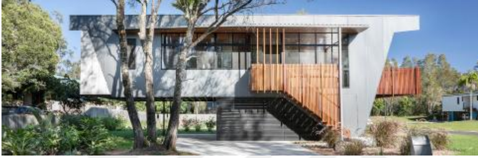
Şekil 4. 47. Northern Rivers Beach House Cephe Elemanları Olan Metal Paneller ve Ahşap (URL-46)
