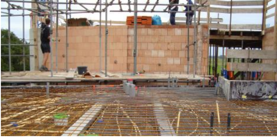
Şekil 4. 41. The Wind House Şantiye Fotoğrafı (URL-43)
