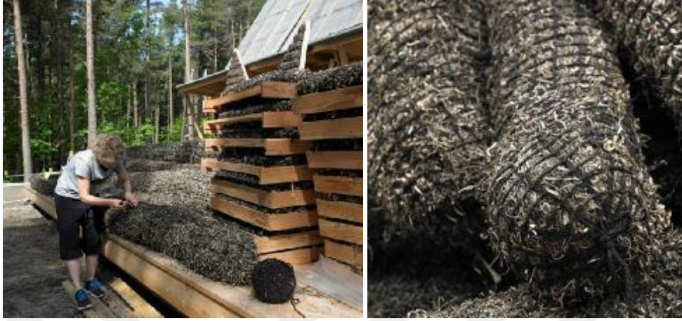
Şekil 4. 28. The Modern Seaweed House Cephe Malzemesi Olarak Yosun Kullanımı (URL-35)
