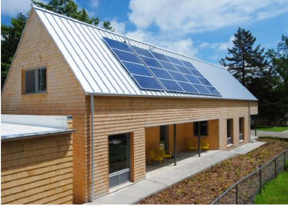
Şekil 5. 4. New York House Çatısında Kullanılan Pv Paneller
