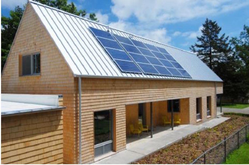
Şekil 4. 44. 1301 New York House Çatıda Kullanılan Kenet Metal Panel Ve Fotovoltaik Panel (URL-45)
