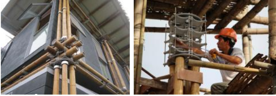
Şekil 4.22. Enerji Verimli Bambu Evi Bambu Direkler Arasında Çelik Bağlayıcılar (URL-32)
