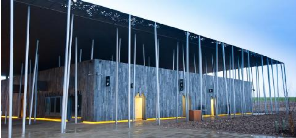
Şekil 4.7. Stonehenge Ziyaret Merkezi Cepheye Yerel Malzeme Uygulaması (URL-23)
