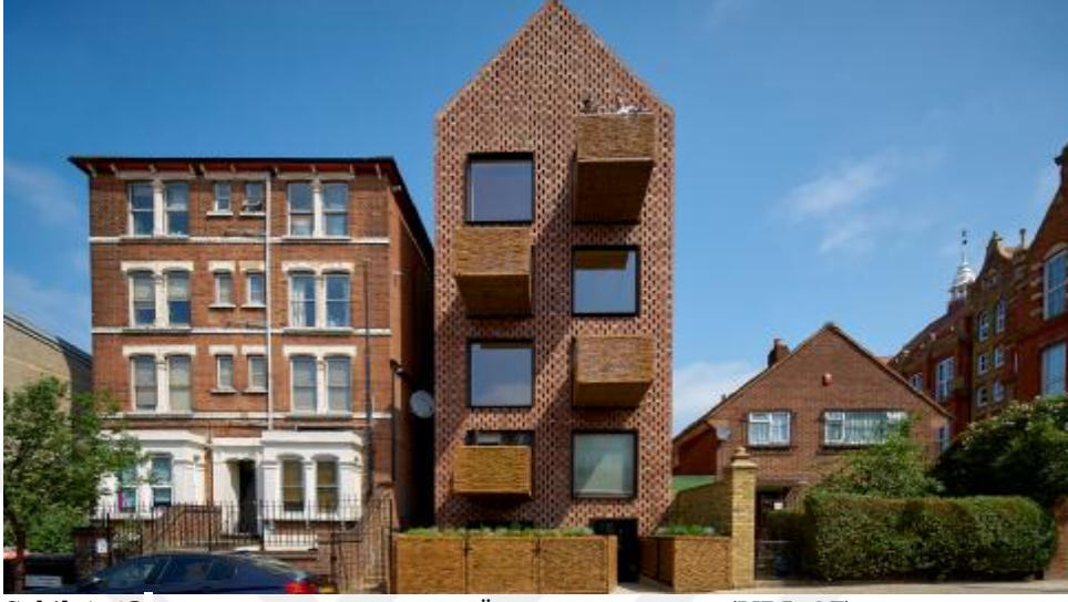
Şekil 4. 13. Barretts Grove Apartmanı Ön Cephe Görünüşü (URL-27)
