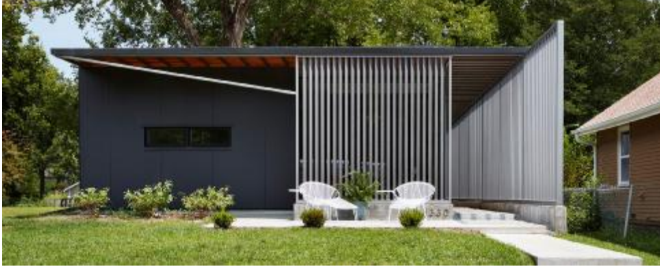
Şekil 4. 51. 1330 Brook House Batı Cephesi (URL-50)
