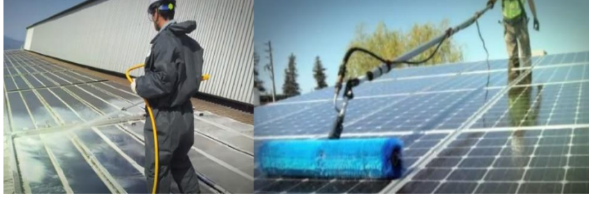
Şekil 2.6 PV panellerin manuel yöntemle temizlenmesi uygulaması.
