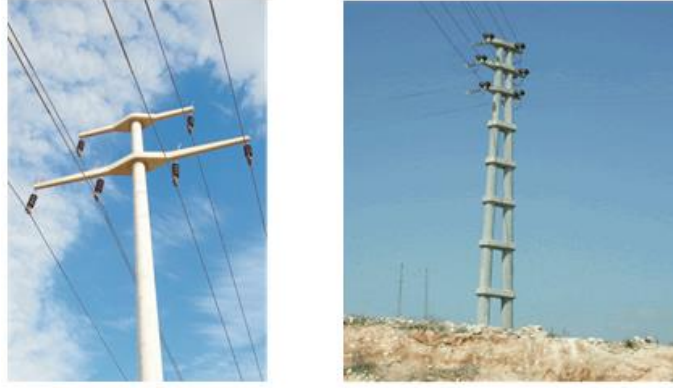
Şekil 3.3. Beton kule tipleri
