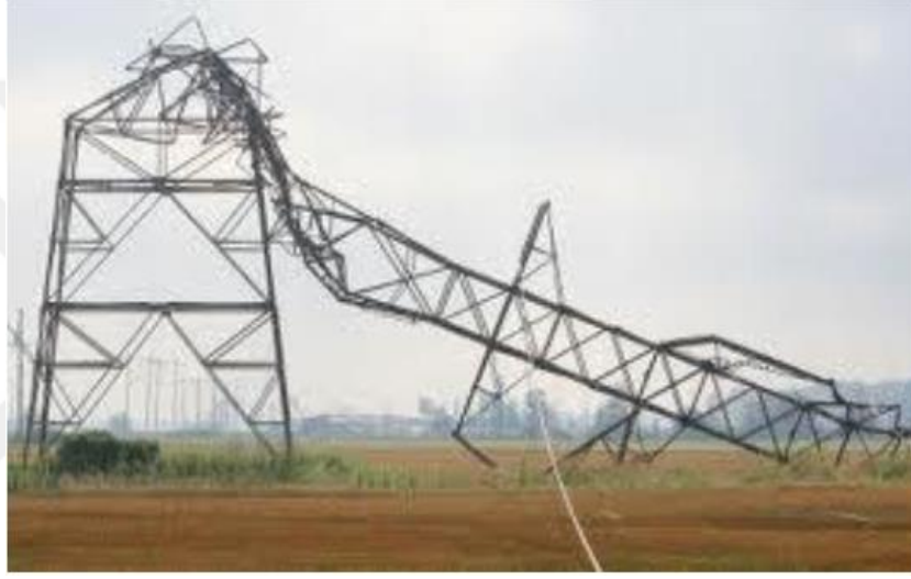
Şekil 1.3. Rüzgardan kaynaklı hasar gören kule (Mahmoud ve ark, 2016)
