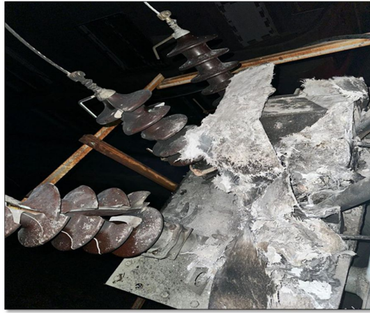
Şekil 3.9. Trafo Üstü OSOS Pano Bağlantı Hatalarından Dolayı Yanması Ve Trafonun Devre Dışı Kalması
