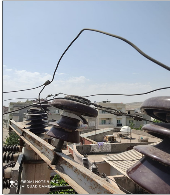
Şekil 3.6. İzolatör Kırılması
