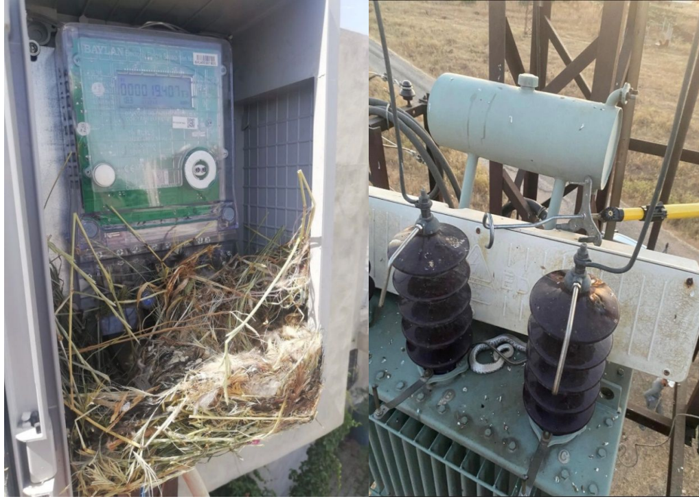
Şekil 3.14. Hayvan kaynaklı oluşan arızalar
