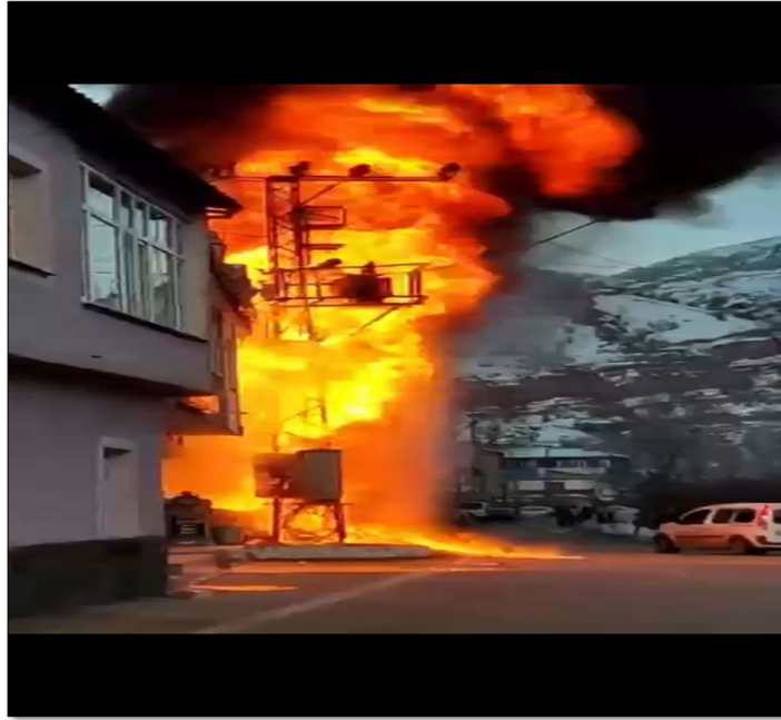
Şekil 3.2. Trafo Alev Alması
