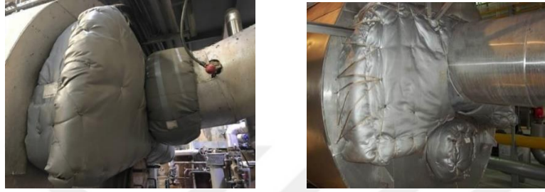
Şekil 5.29. Duman borusu için önerilen yalıtım ceket ve yastığı
