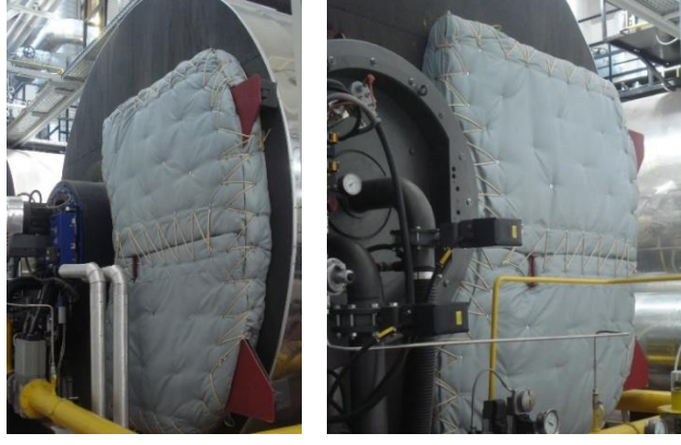
Şekil 5.24. Ön kapak için önerilen yalıtım ceket
