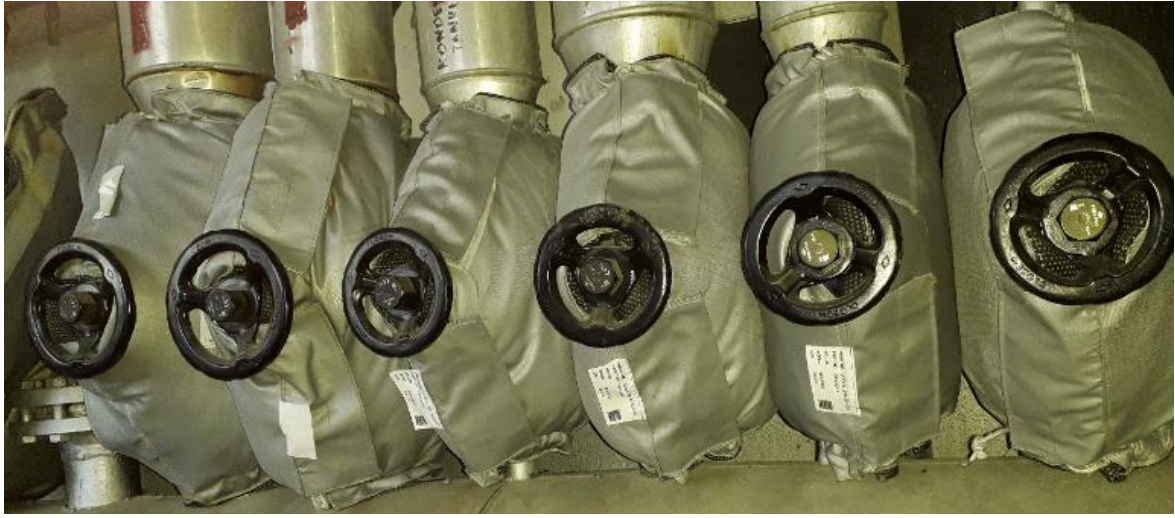
Şekil 5.36. Dağıtım hatlarında vana ceketleri uygulaması
