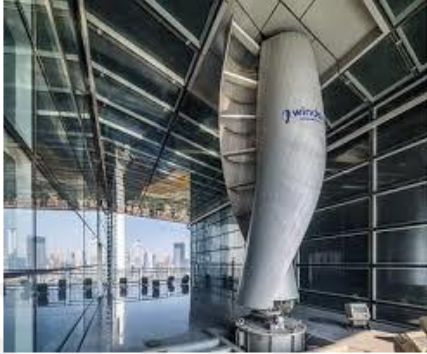
Şekil 38: Pearl River Tower Rüzgar Türbini
