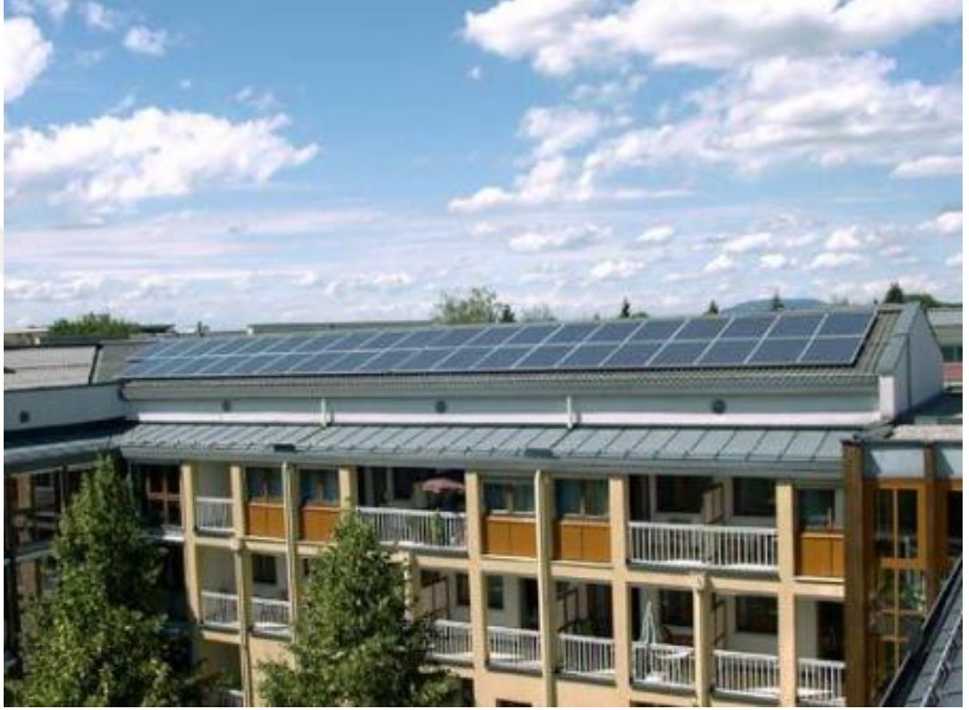
Şekil 11: Grödig Huzurevi PV Örneği
