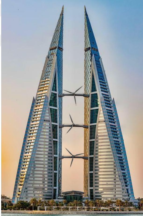
Şekil 34: Bahrain World Trade Center Türbin Örneği
