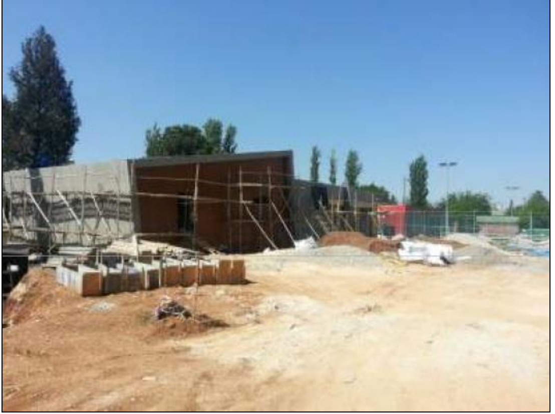
Resim 3.15. Pasif ev projesi uygulama fotoğrafı [131]
