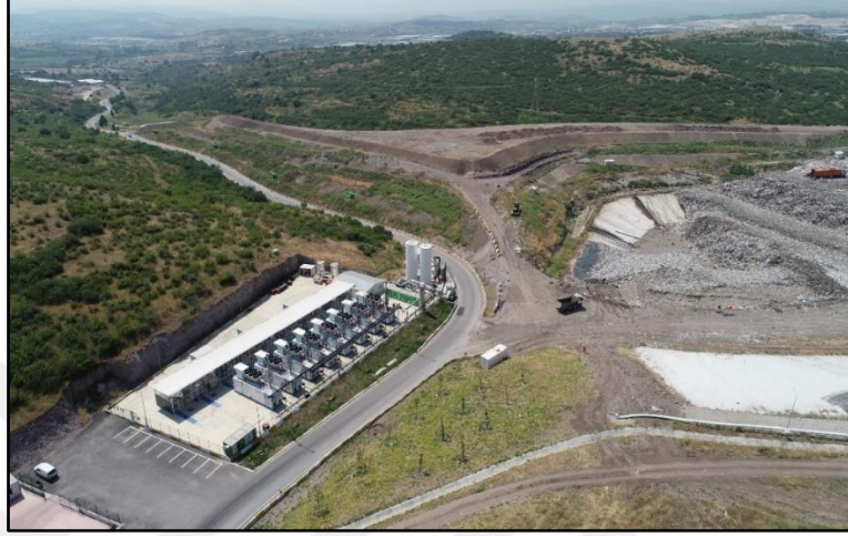
Şekil 4-3. Çöp gazından elektrik üretim tesisi
